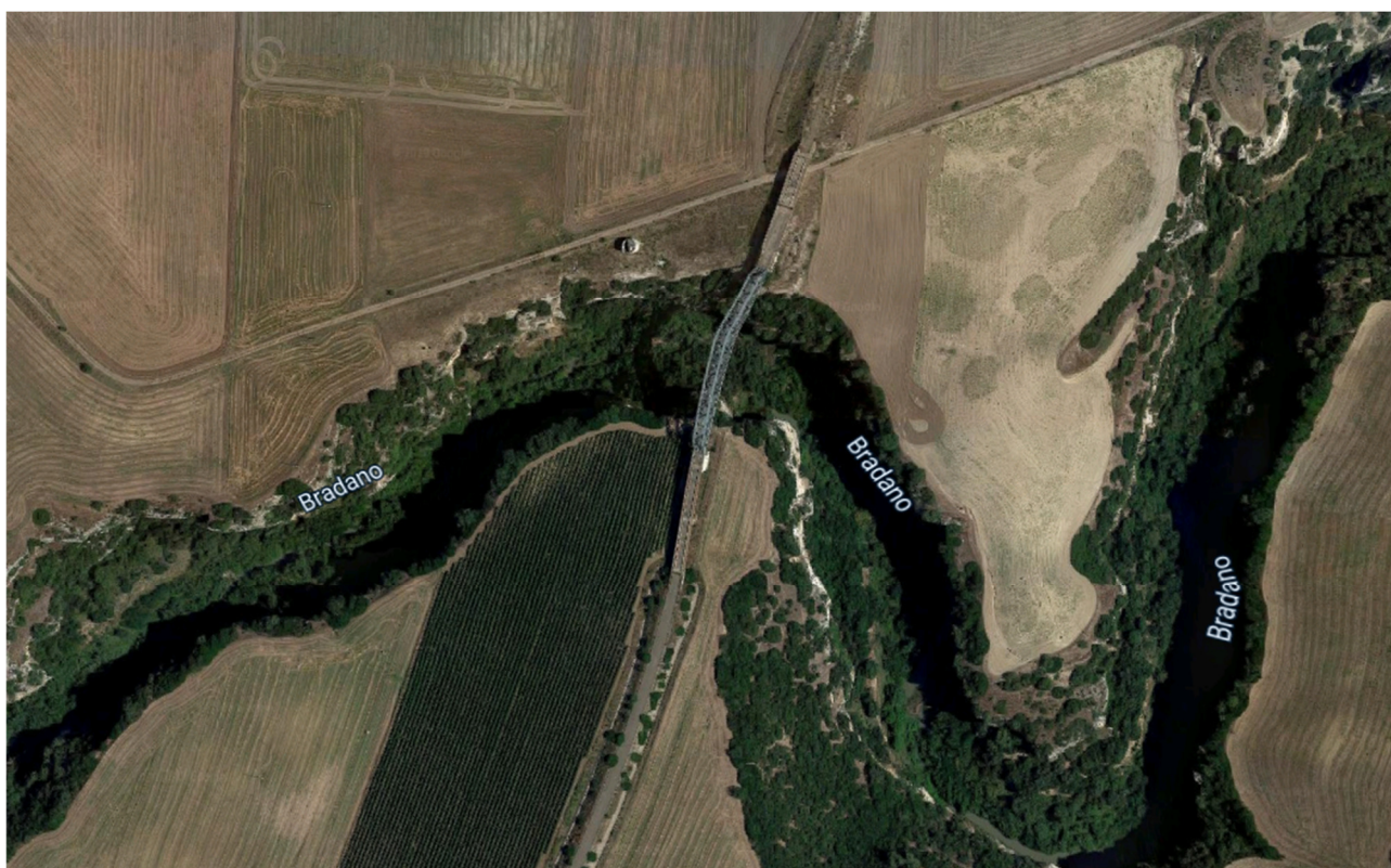
Figura 1 – Viadotto Bradano (VI05) della linea Ferrandina-Matera
