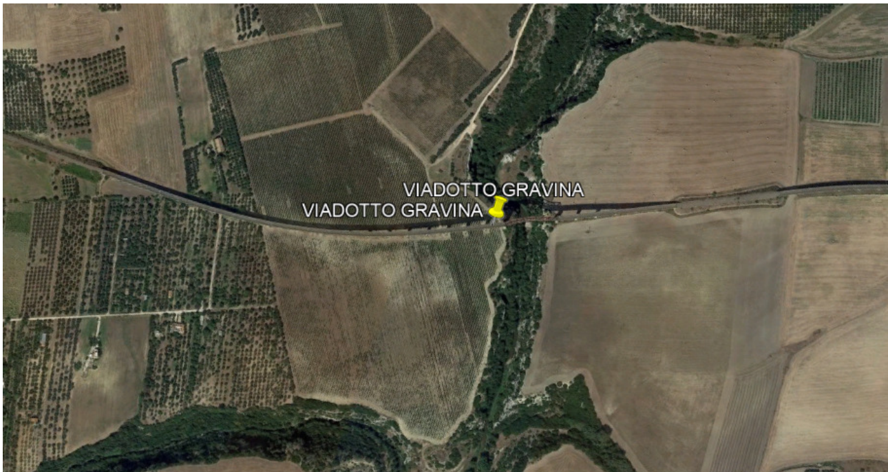
Figura 1 – Viadotto Gravina (VI08) della linea Ferrandina-Matera
