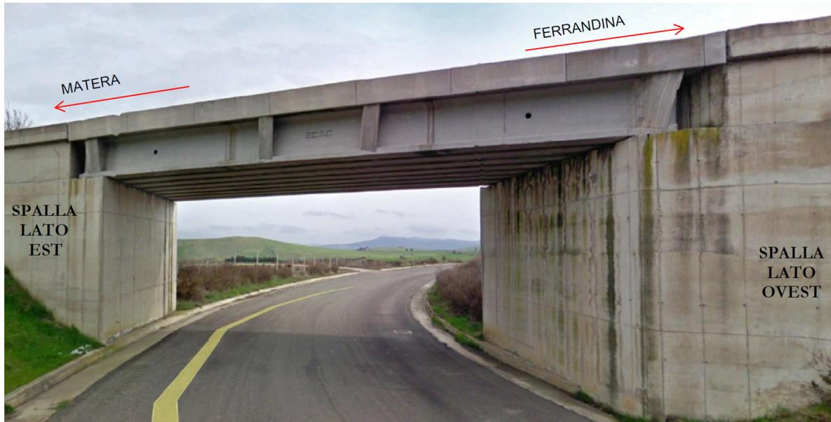
Figura 2: Vista dal piano stradale dell'opera con indicazione della disposizione delle spalle lato EST e OVEST.
