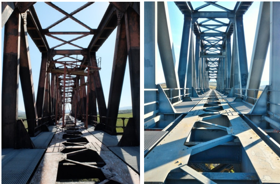
a - Viadotto Gravina; b – Viadotto Bradano
