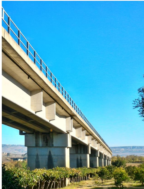
Vista di un viadotto tipo della linea Ferrandina-Matera
