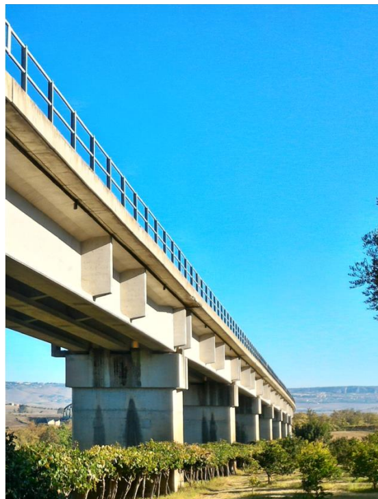
Vista di un viadotto tipo della linea Ferrandina-Matera
