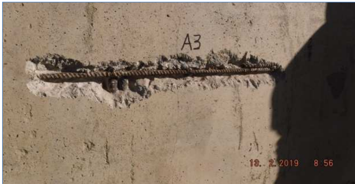
Rilievo diretto armature - Barre verticali \phi=24 mm Barre orizzontali \phi=14 mm
