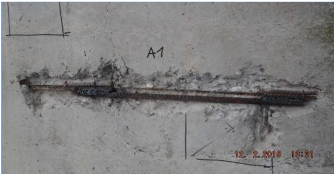
Rilievo diretto armature - Barre verticali \phi=30 mm Barre orizzontali \phi=14 mm
