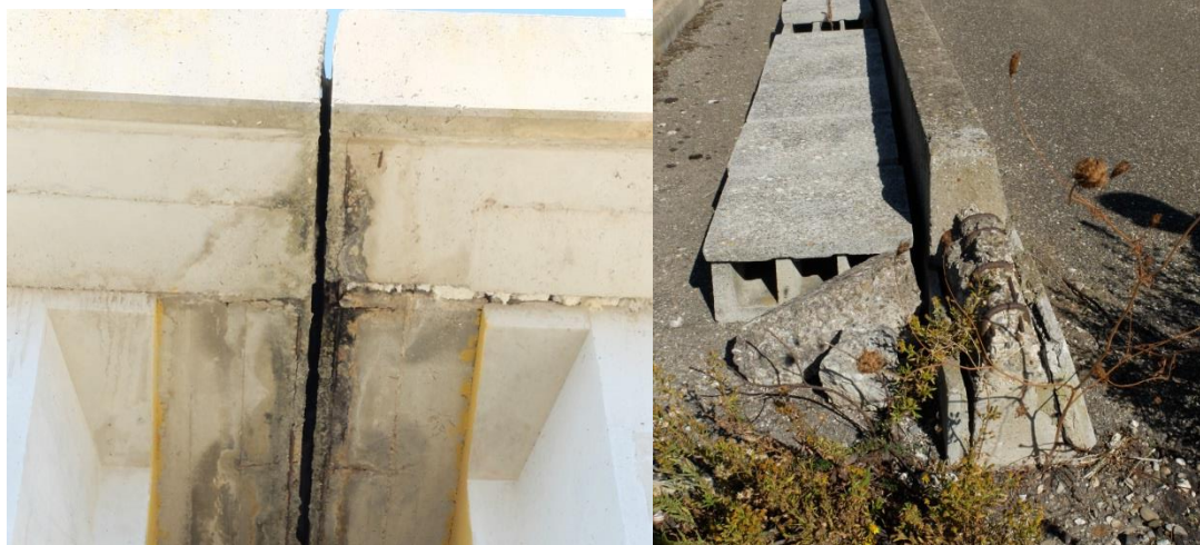
a) - Giunto di impalcato; b) – muretti paraballast su spalla/ impalcato
