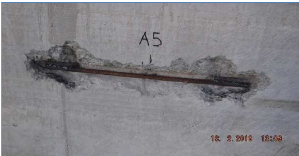
Rilievo diretto armature - Barre verticali \phi=16 mm Barre orizzontali \phi=14 mm
