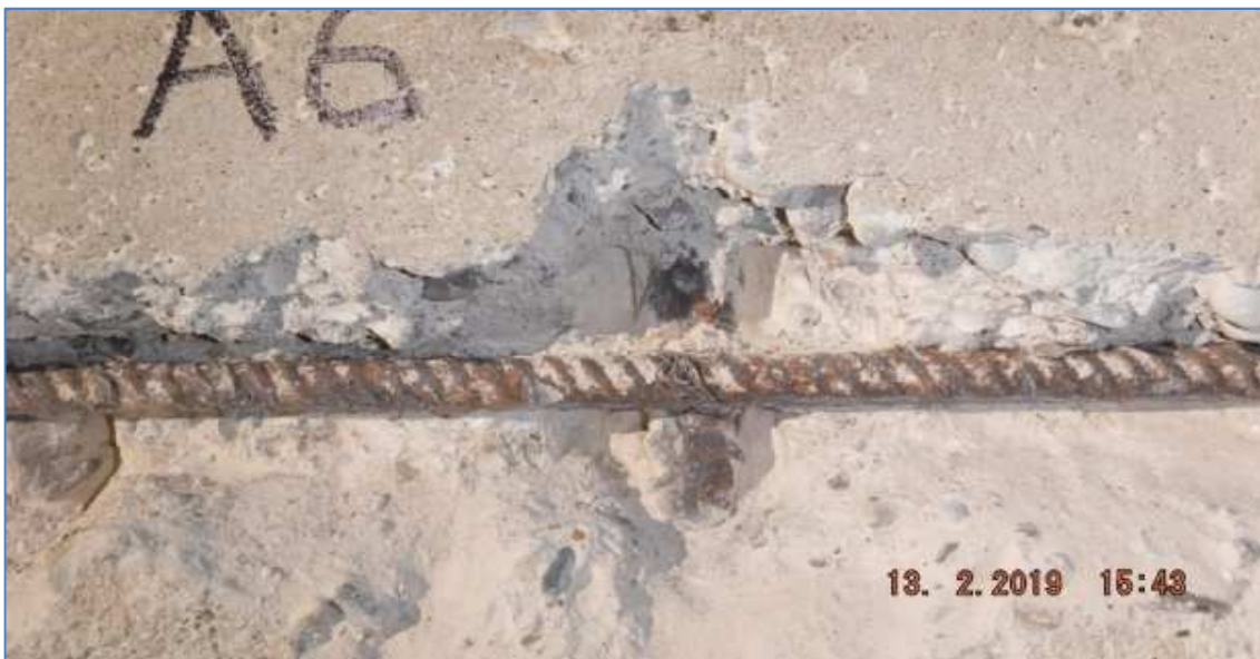
Rilievo diretto armature - Barre verticali \phi=20 mm Barre orizzontali \phi=14 mm
