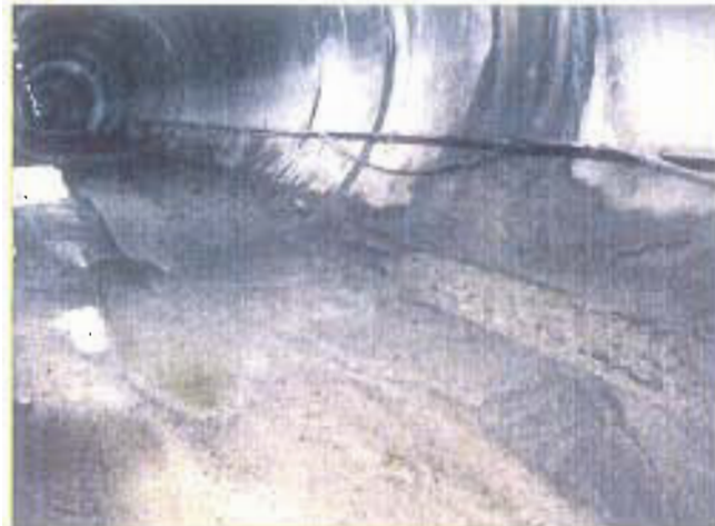
materiale argilloso trasportato dall'acqua di infiltrazione
