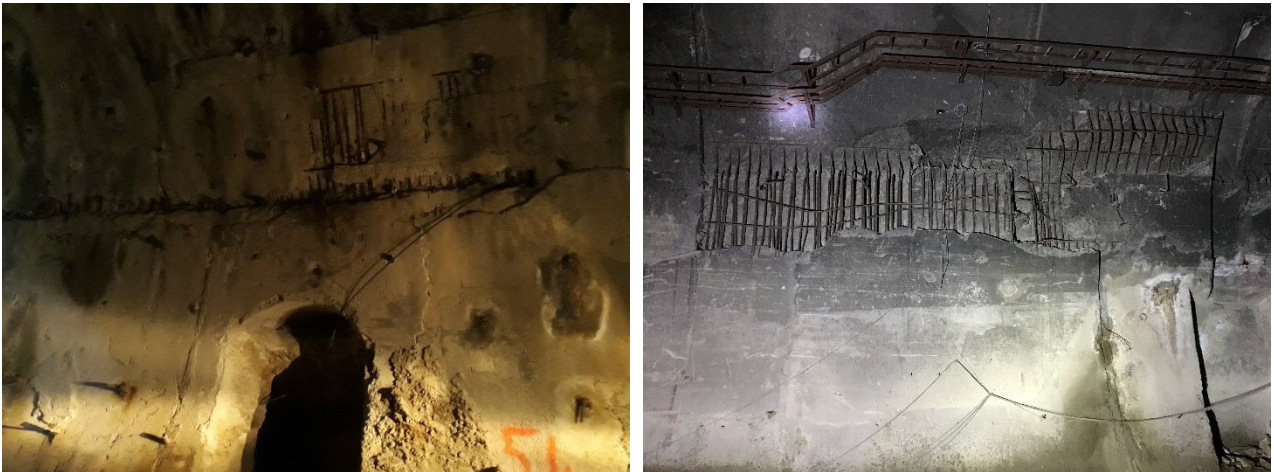
Figura 12. Ferri dell'armatura a vista
