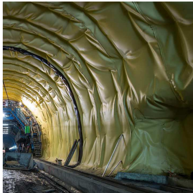
Figura 13. Esempi di impermeabilizzazione full round: arco rovescio, murette e nicchie (a sinistra); calotta, murette e nicchie (a destra)
