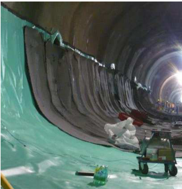
Figura 13. Esempi di impermeabilizzazione full round: arco rovescio, murette e nicchie (a sinistra); calotta, murette e nicchie (a destra)
