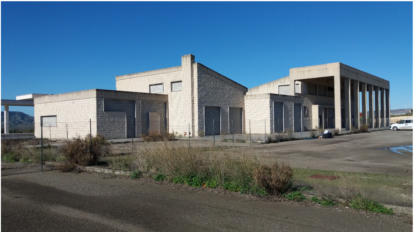
Vista del Fabbricato oggetto di intervento
