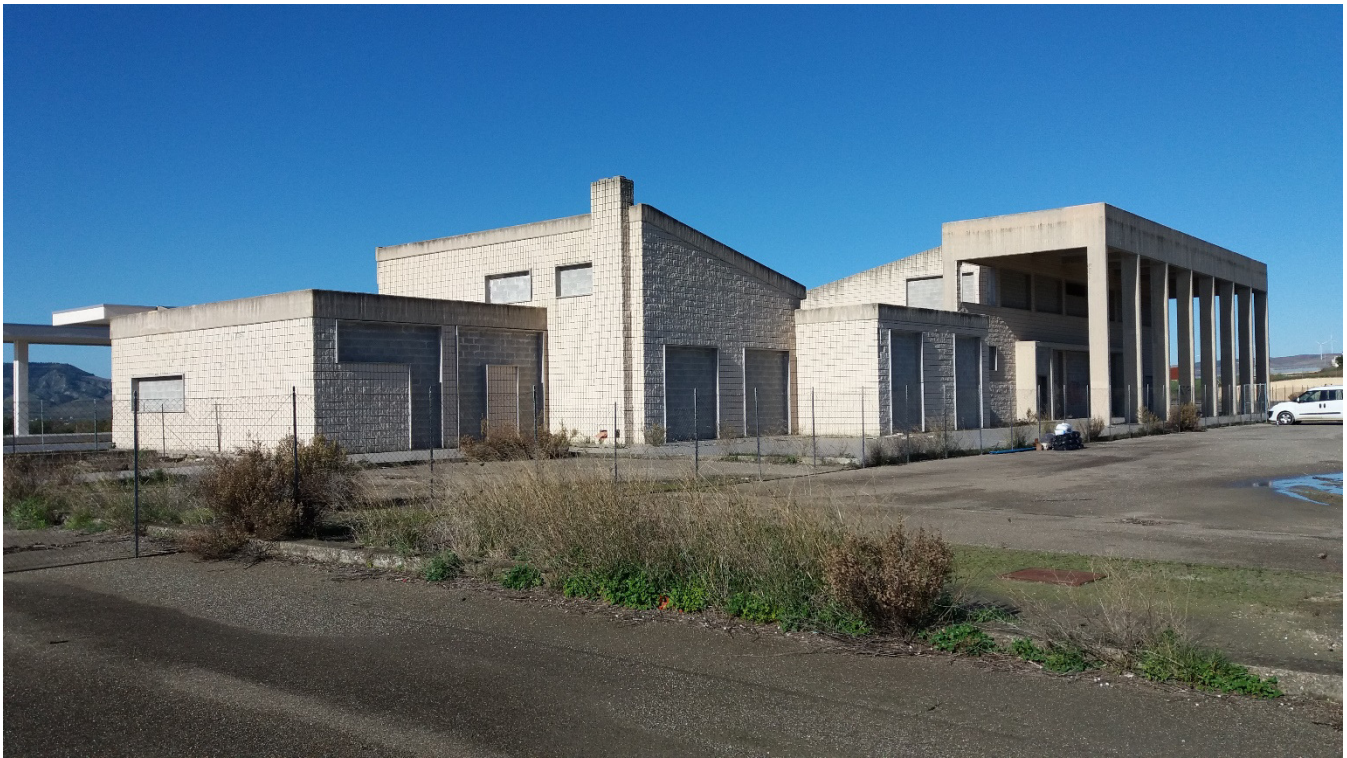
Vista del Fabbricato oggetto di intervento
