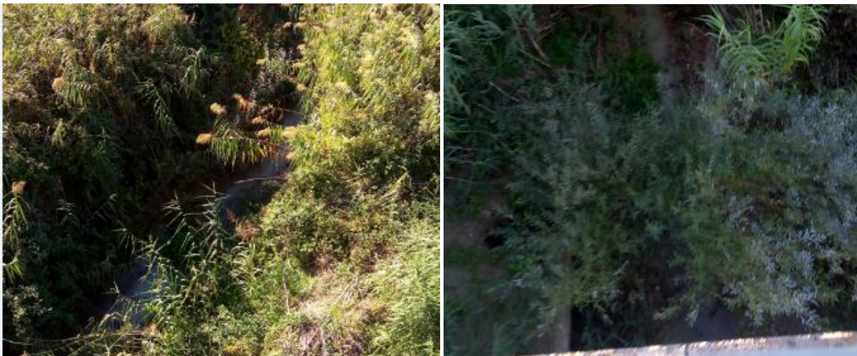
Figura 11 – Viadotto esistente sul Rio Conche: condizioni dell’alveo allo stato attuale.
