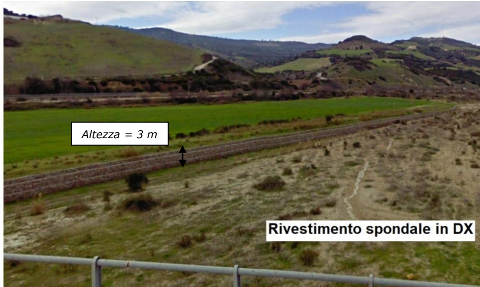
Figura 51 – Particolare delle opere di sistemazione spondali in destra idraulica del F. Basento.
