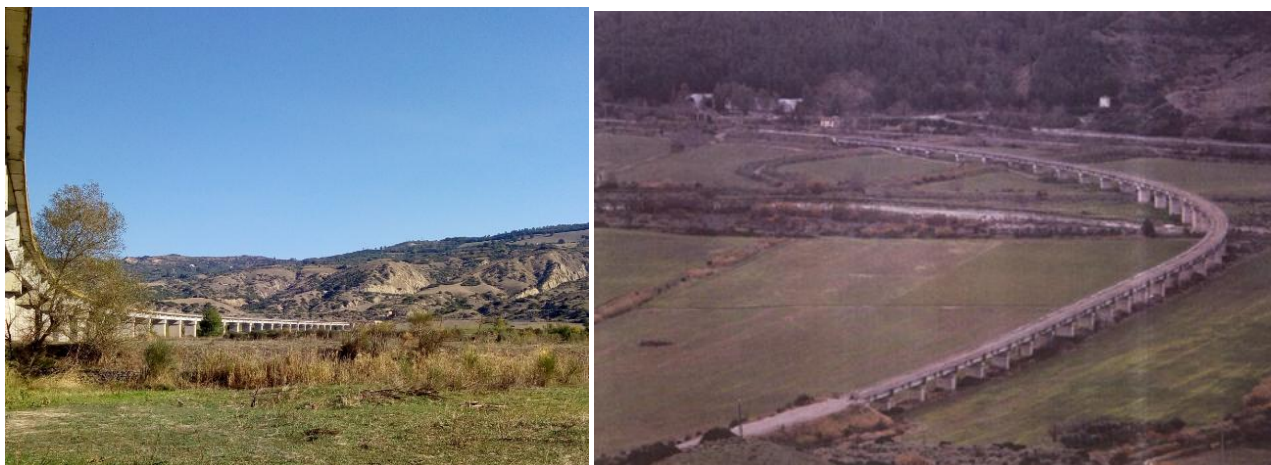
Figura 7 – Viadotto esistente VI01 sul Fiume Basento.
