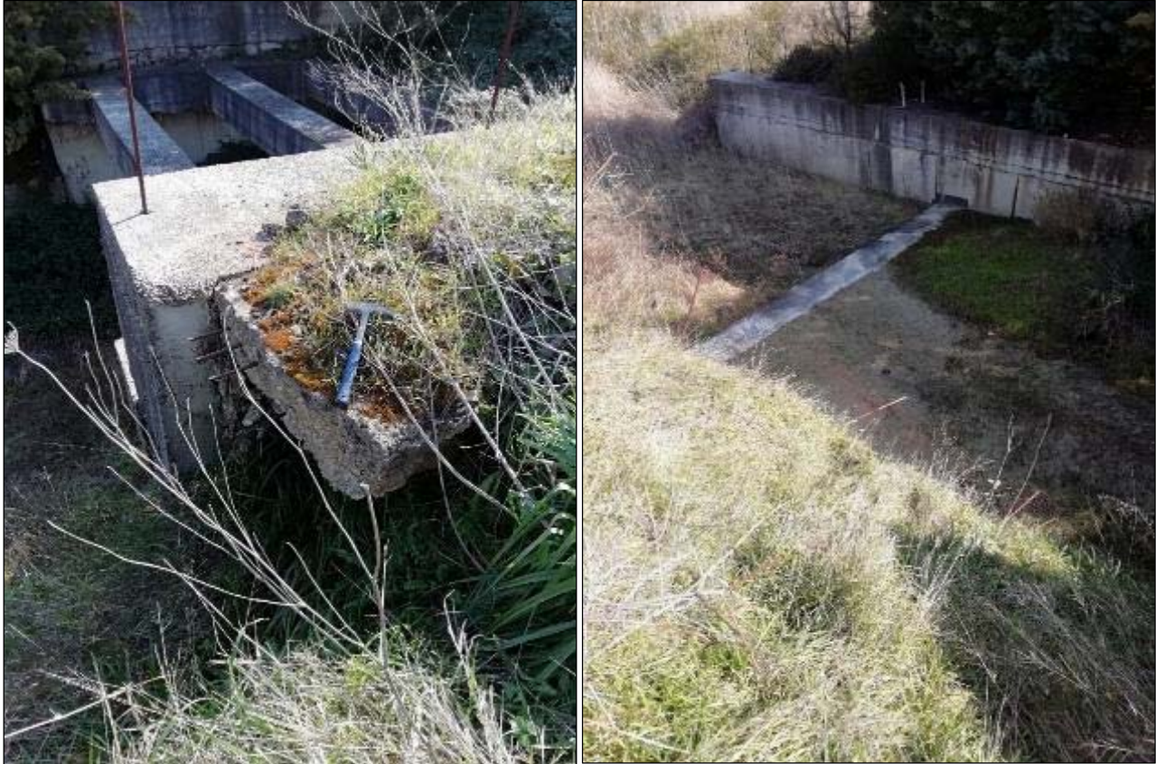
Figura 13-30 e Figura 13-31 - A sinistra erosione della spalla dell'opera con rimozione di materiale eluvio-colluviale e a destra recinzione di protezione abbattuta con accumulo di materiale in piccoli dossi (F.3).
