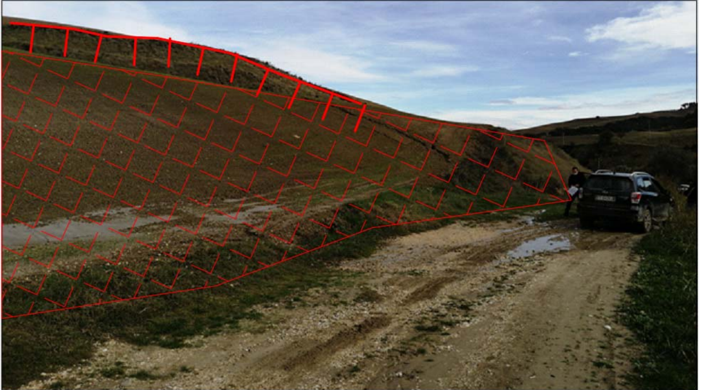
Figura 13-39 – Posizione della viabilità rispetto al corpo di frana.
