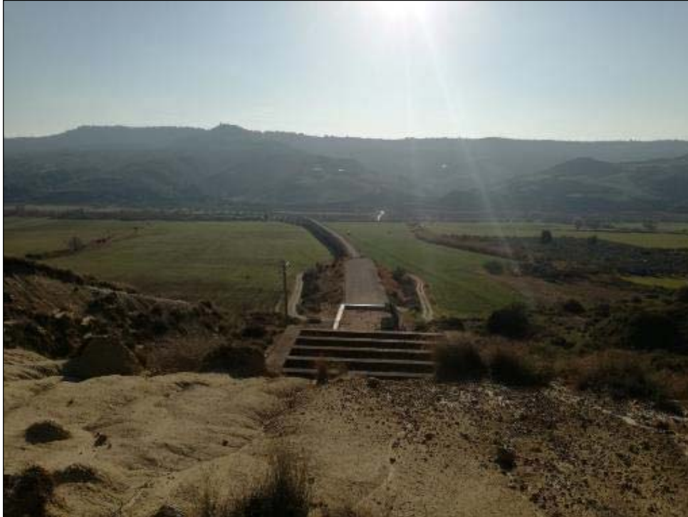
Figura 13-9 - Scarpata sovrastante l'imbocco lato Matera. Visibili in primo piano solchi da ruscellamento (F.3).
