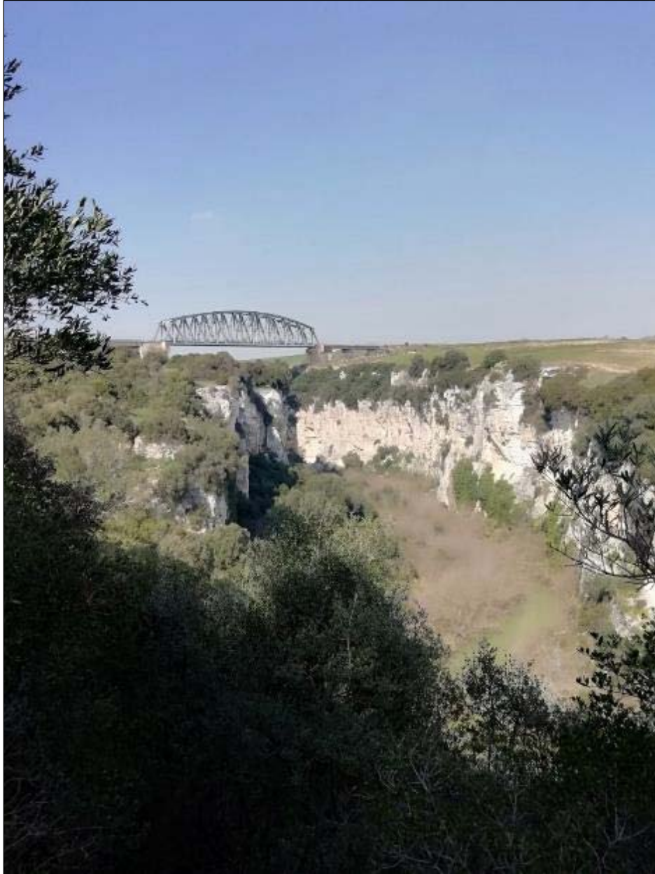
Figura 13-42 - Canyon del fiume Bradano e travata metallica della linea Ferrandina-Matera
