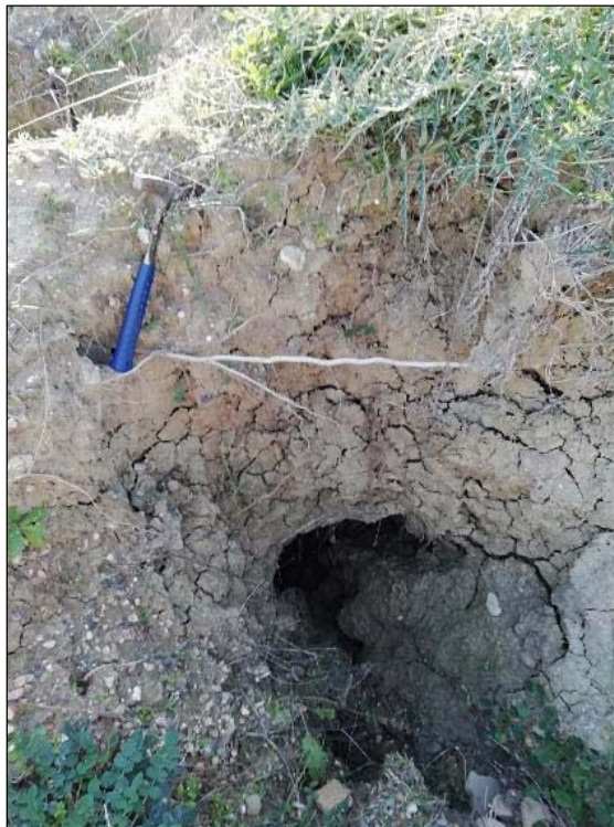
Figura 13-16 - Imbocco della cavità ipogea (F.7)
