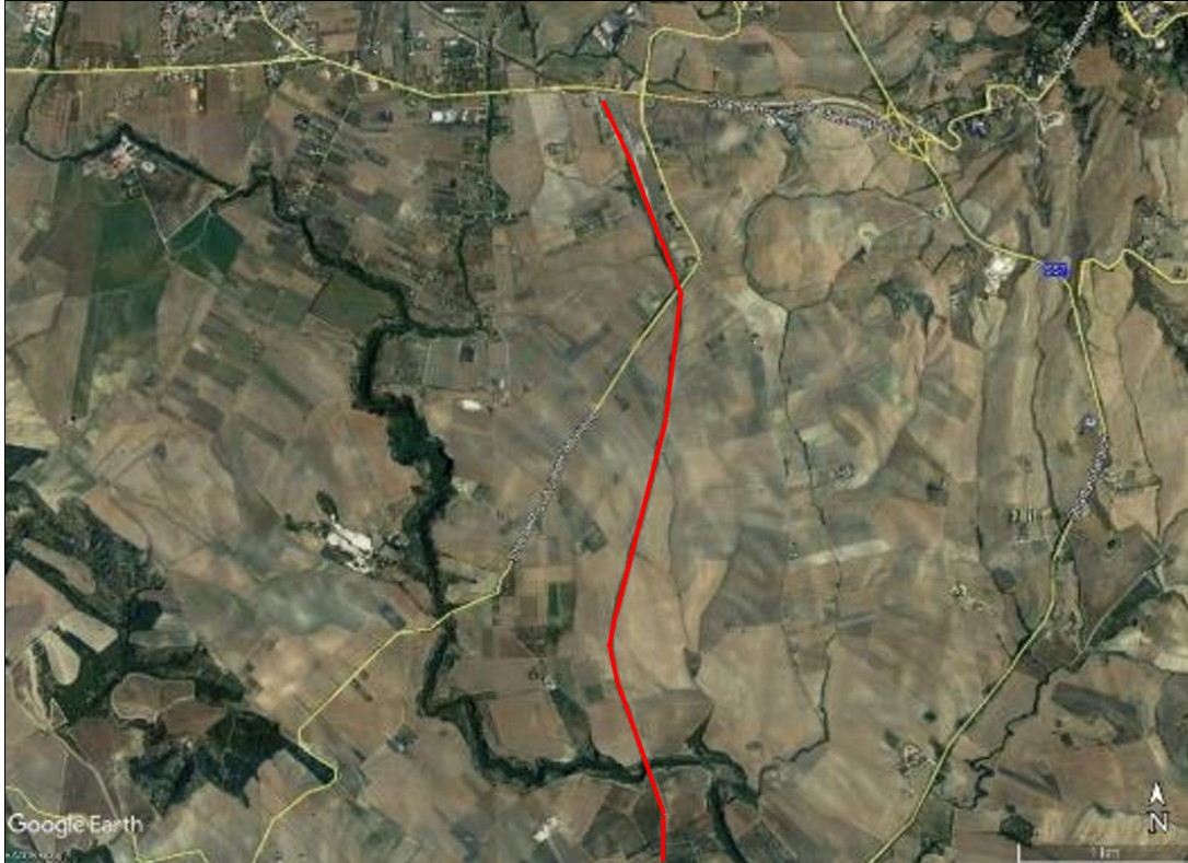
Figura 3-6 - Immagine aerea della linea oggetto di studio presso sino alla stazione de La Martella (Google Earth).
