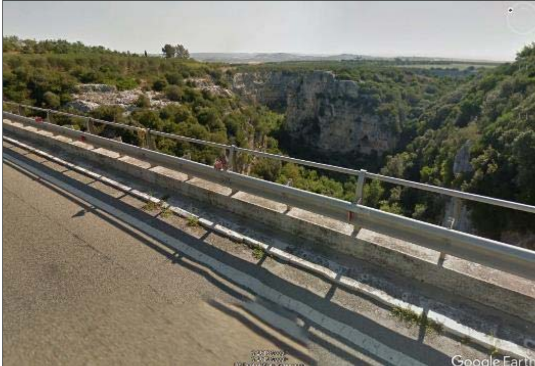
Figura 13-43 – Canyon del Torrente Bradano visto dal ponte della SS7, circa 500 m a est della travata metallica.
