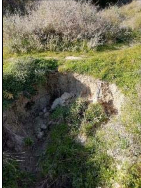
Figura 13-7 - Sprofondamento del terreno causato dalla circolazione idrica sotterranea (F.5)
