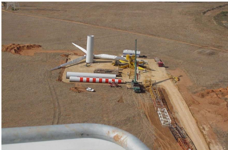
Figura 4 – Piazzola per il montaggio dell'aerogeneratore
