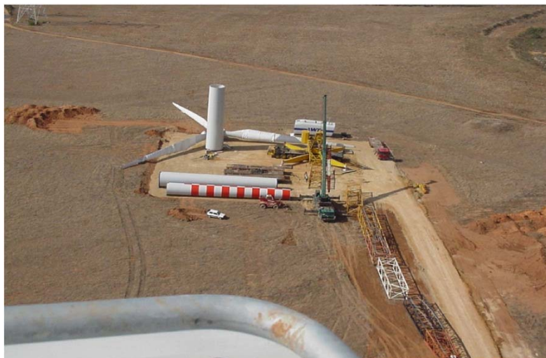
Figura 24 – Piazzola per il montaggio dell'aerogeneratore
