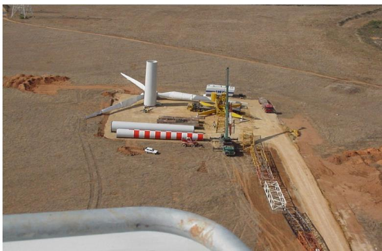
Figura 9 – Piazzola per il montaggio dell'aerogeneratore
