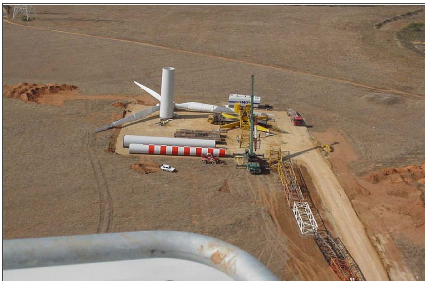
Foto 1. Piazzola per il montaggio dell'aerogeneratore
