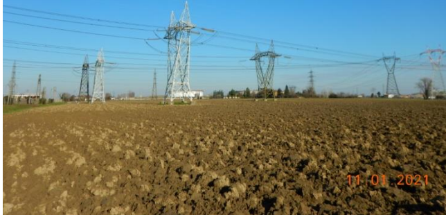
Figure 5aa PV 23, da Nord
