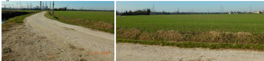
Figure 5u PV 19 da Est
