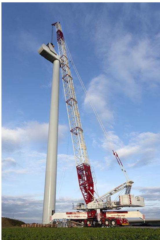
Figura 12 – Una gru tipo Liebherr 1750 durante l'installazione di un generatore eolico
