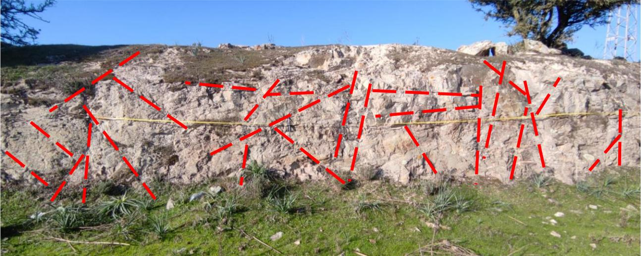
Figura 7.3: Vista sull'affioramento dei Porfiroidi (PRFa-1) con le tracce dei giunti di fratturazione (in rosso).
