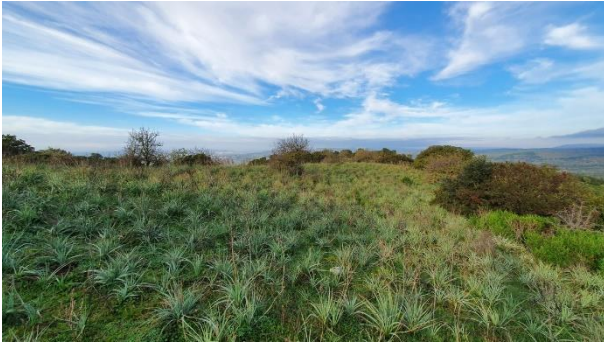
Figura 76. Tracciato del cavidotto presso WTG003, vista da SE.
