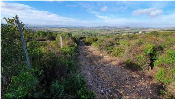
Figura 82. Tracciato del cavidotto presso WTG005, vista da ESE.
