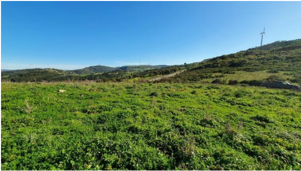
Figura 74. Tracciato del cavidotto presso WTG001, vista da NW.
