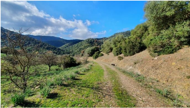
Figura 90. Tracciato del cavidotto presso WTG012, vista da NE.
