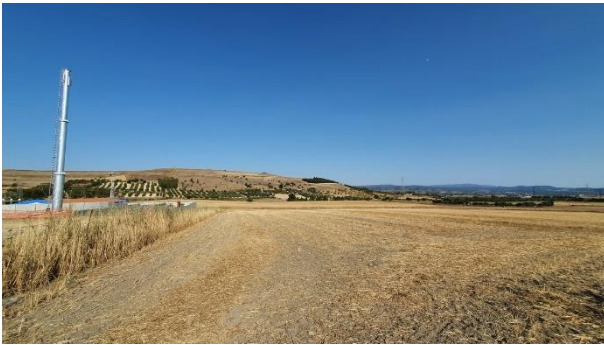
Figura 71. Area della SSEU, vista da NW.
