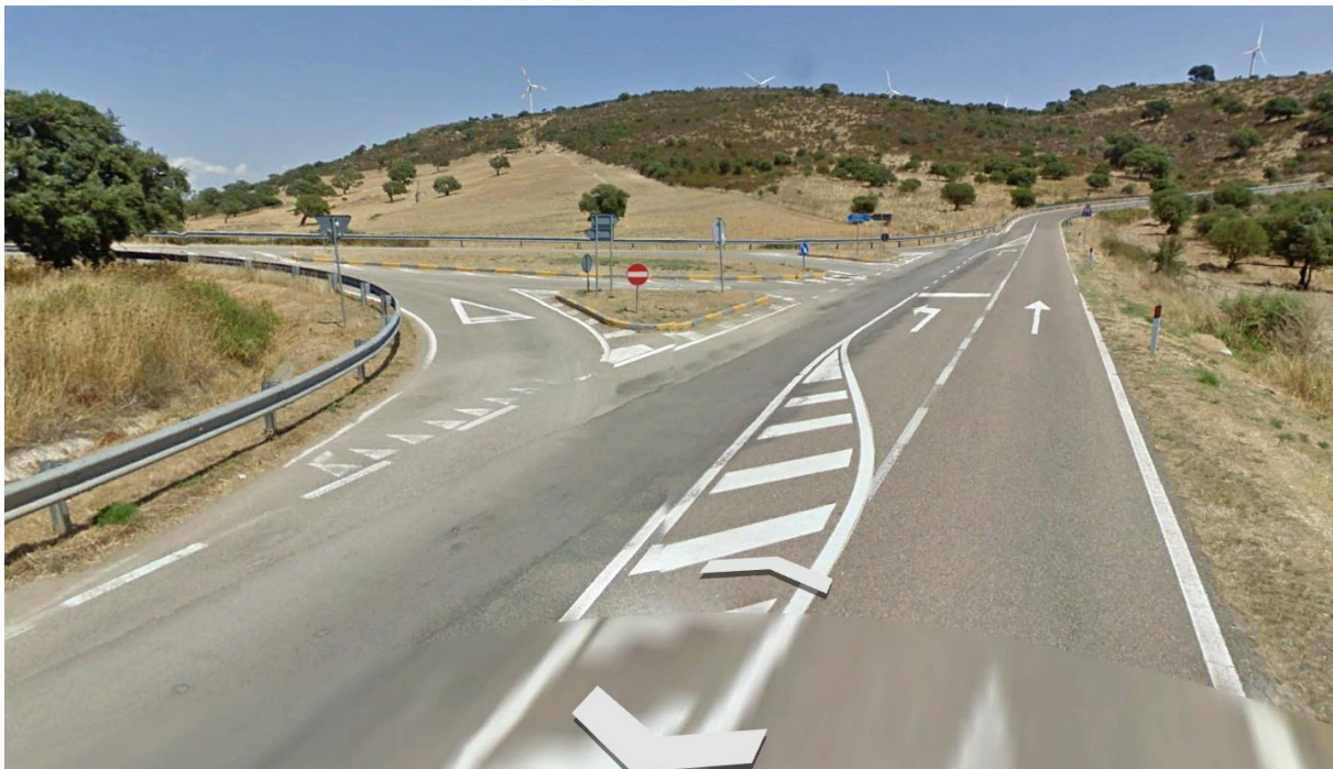
Immagine 16 – Vista frontale 1 svincolo immssione area impianto
