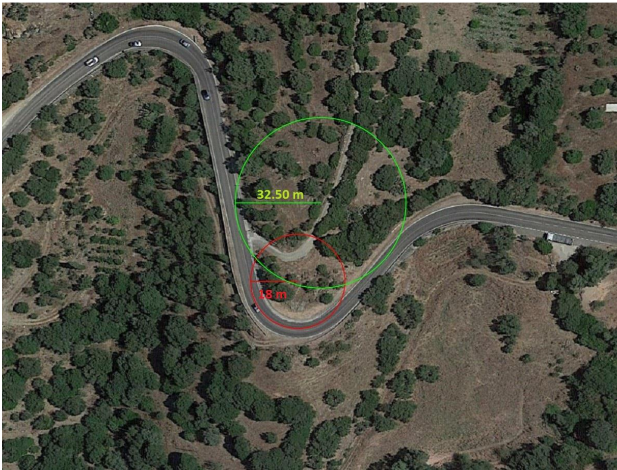
Immagine 13 – Tornante soggetto a sbancamento
