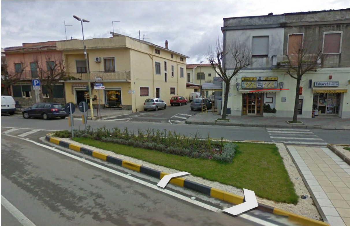
Immagine 9 – Demolizione spartitraffico centro urbano Senorbì (SU)
