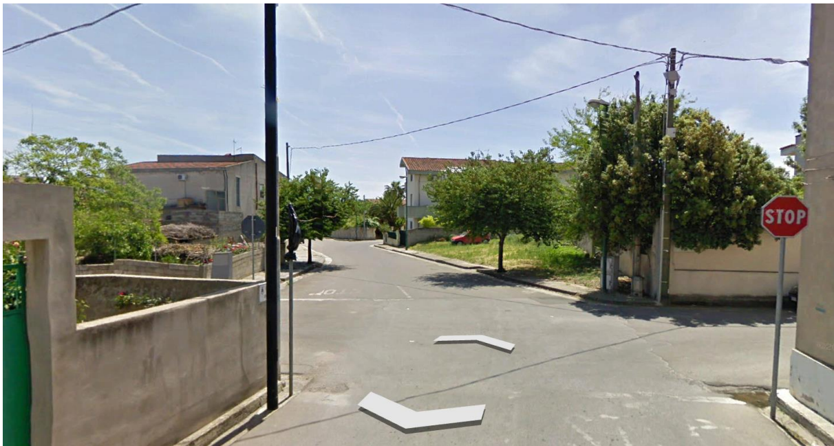
Immagine 10 – Ristemazione linee aeree elettriche centro urbano Senorbì (SU)
