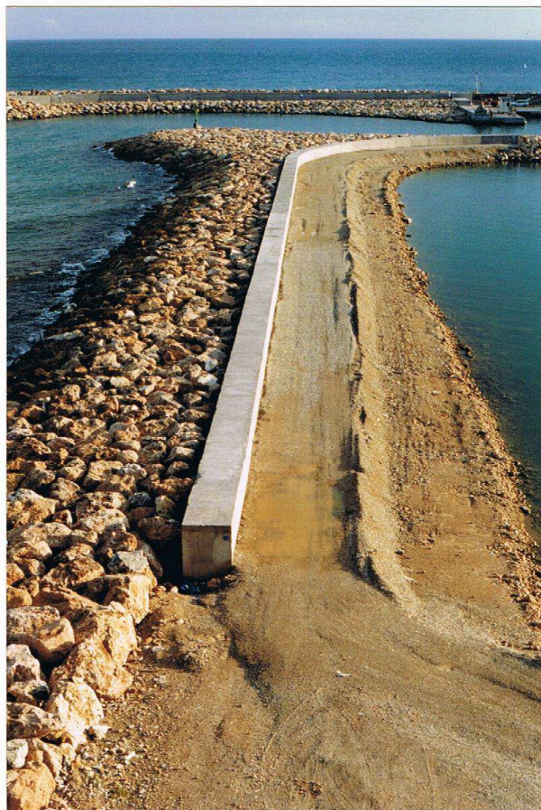
Il muro in fase di costruzione della diga di sottoflutto
