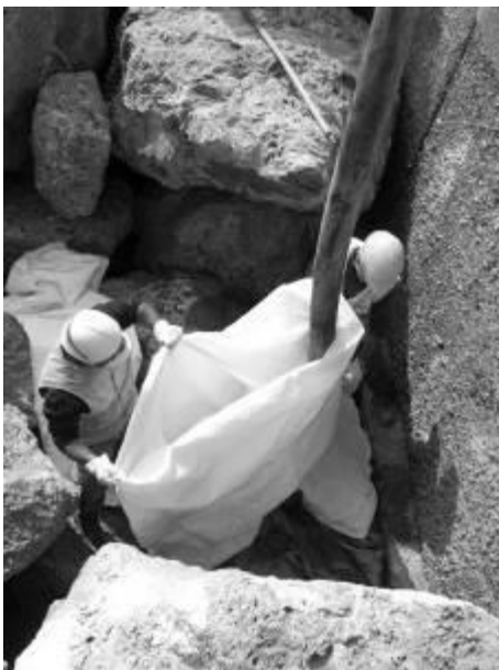
Fasi di esecuzione del riempimento dei sacchi con il calcestruzzo
