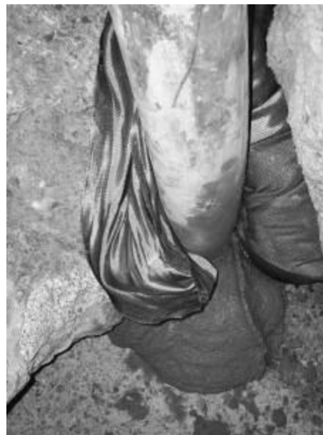
Fasi di esecuzione del riempimento dei sacchi con il calcestruzzo
