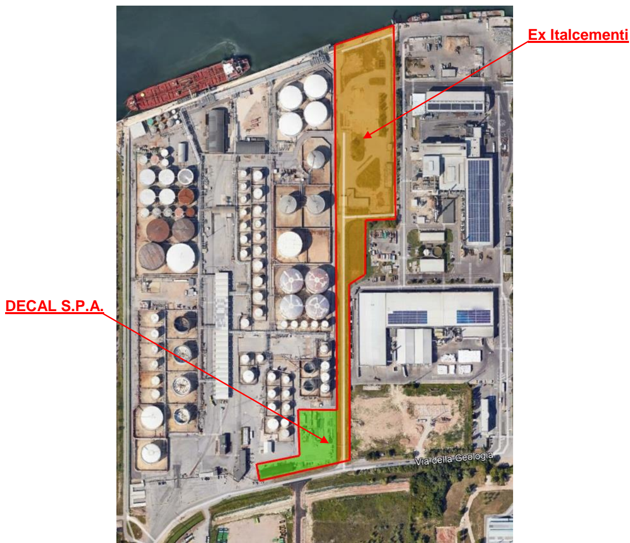
Fig. 2.2 – Dettaglio delle aree Decal (verde) ed Ex Italcementi (arancione) – (fonte Google Earth)
