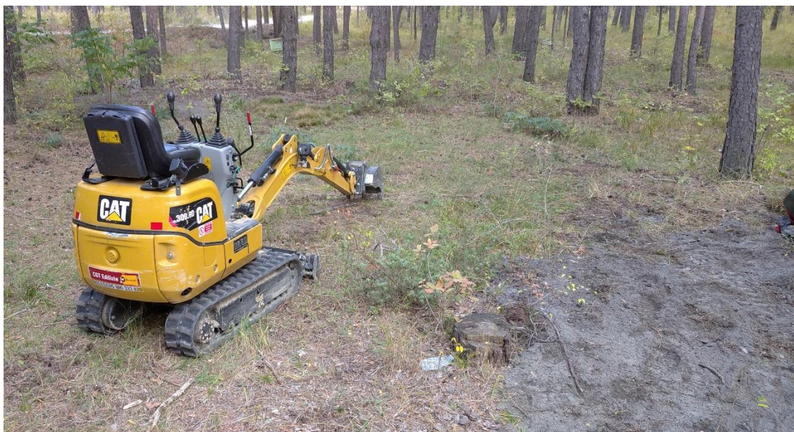
Figura 4 – Mini escavatore utilizzato per la realizzazione delle buche in cui alloggiare le zolle di Carex alba
