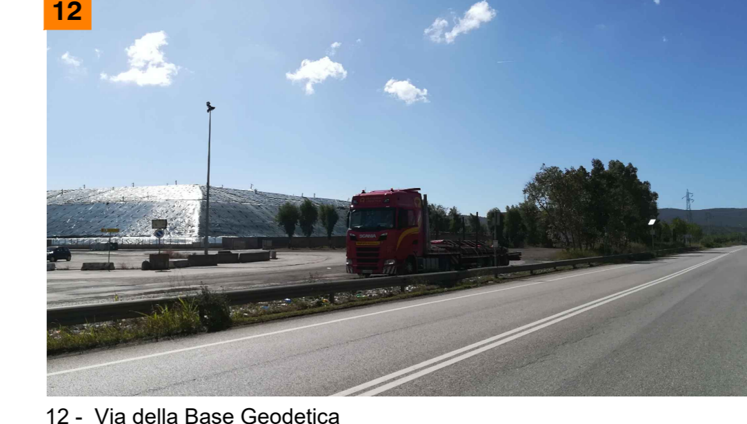
12 - Via della Base Geodetica
