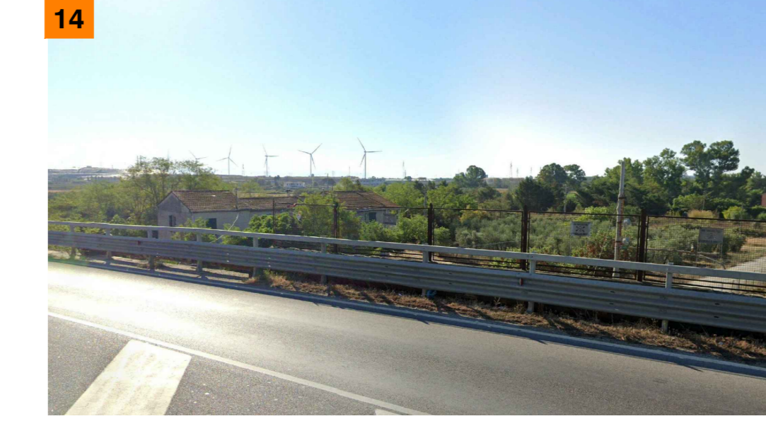
14 - Via della Base Geodetica
