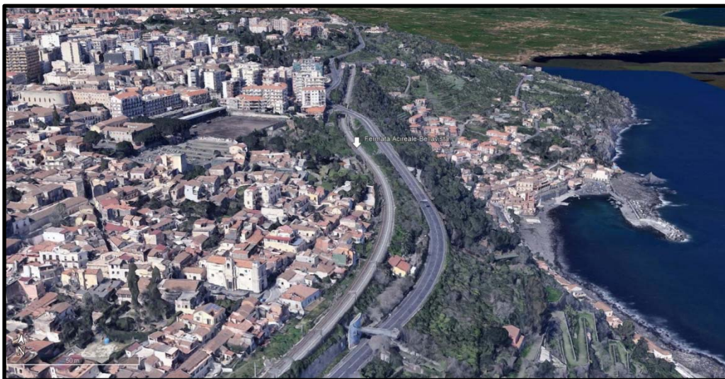
Figura 4 – Vista aerea di contesto
