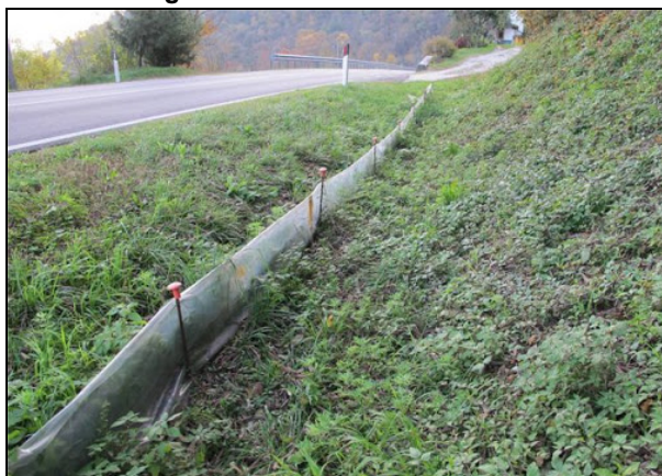
Fig. 11/d – Barriera per erpetofauna esempio con telo in polietilene fermato da picchetto in ferro ed ancorato al terreno con filo di ferro e ganci ad “U” rovescio
