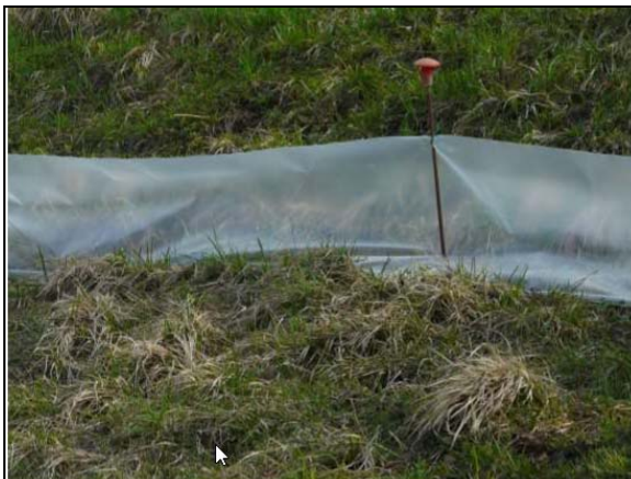
Fig. 11/C – Barriera per erpetofauna esempio con telo in polietilene fermato da picchetto in ferro ed ancorato al terreno con filo di ferro e ganci ad “U” rovescio
