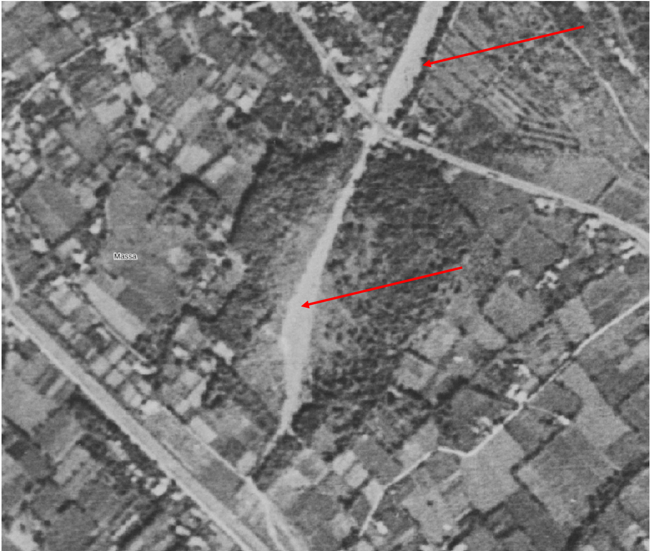
Fig. 4.5. Canal Magro nel tratto compreso tra la SS1 Aurelia e la ferrovia. Ben evidente, anche a monte della SS1 Aurelia, l'alveo del Canal Magro a seguito di un evento che ha comportato abbondante deposizione ed a parziale a esondazione. Immagine OFC 10K del 1954. ( http://www502.regione.toscana.it/geoscopio/fototeca.html ).
