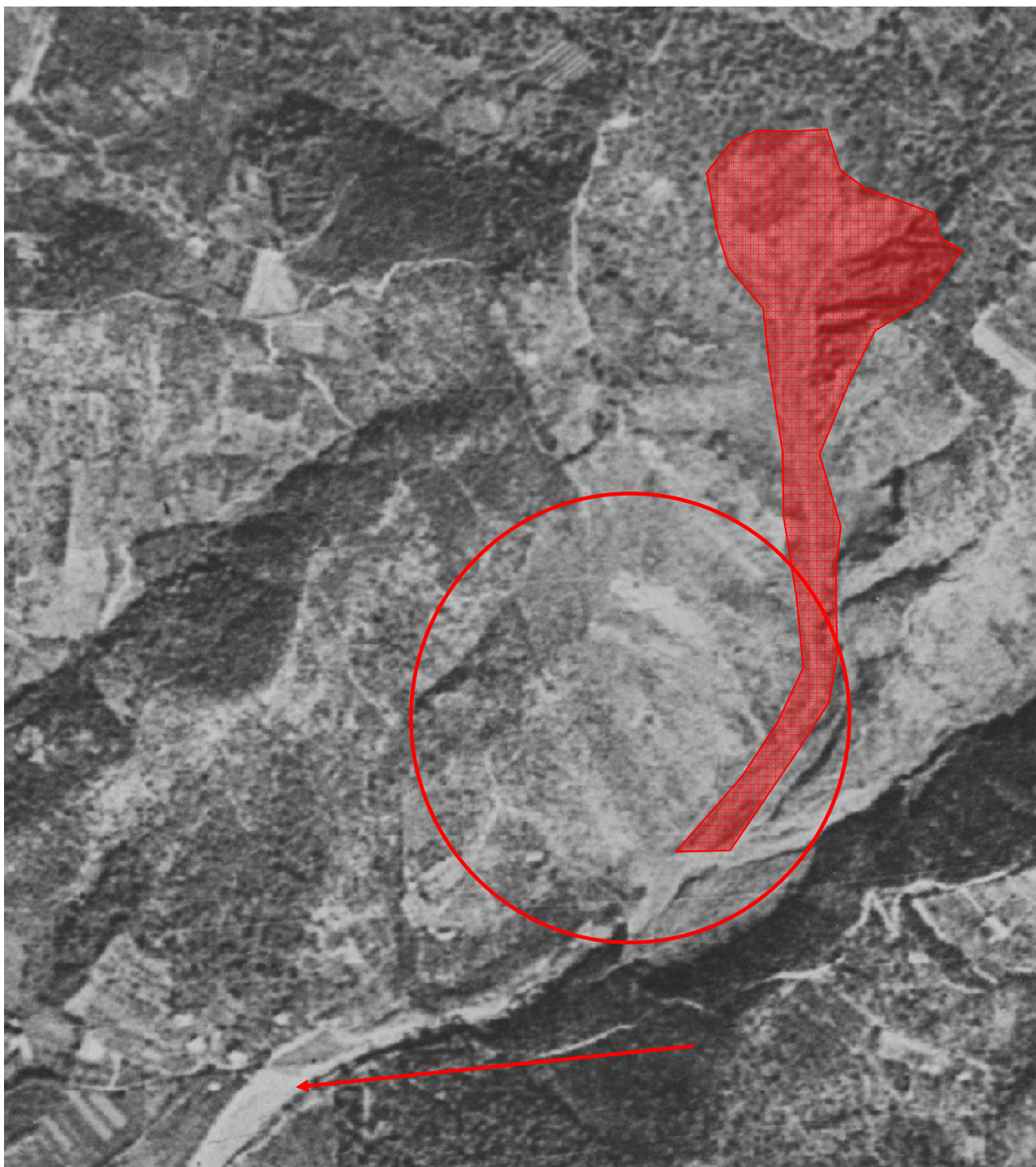
Fig. 4.7. Tratto del Canalmagro a monte della SS1 Aurelia. Evidenti le tracce di erosione sul versante in destra idraulica. La freccia rossa indica le evidenze di depositi in alveo che sono particolarmente sviluppati a valle dell'area in erosione. Immagine OFC 10K del 1954 ( http://www502.regione.toscana.it/geoscopio/fototeca.html )
