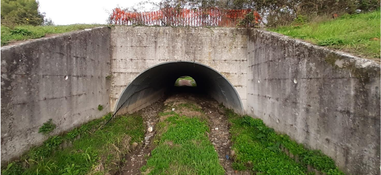
Figura 23 – Torrente Canalmagro - Attraversamento idraulico Via delle Jare
