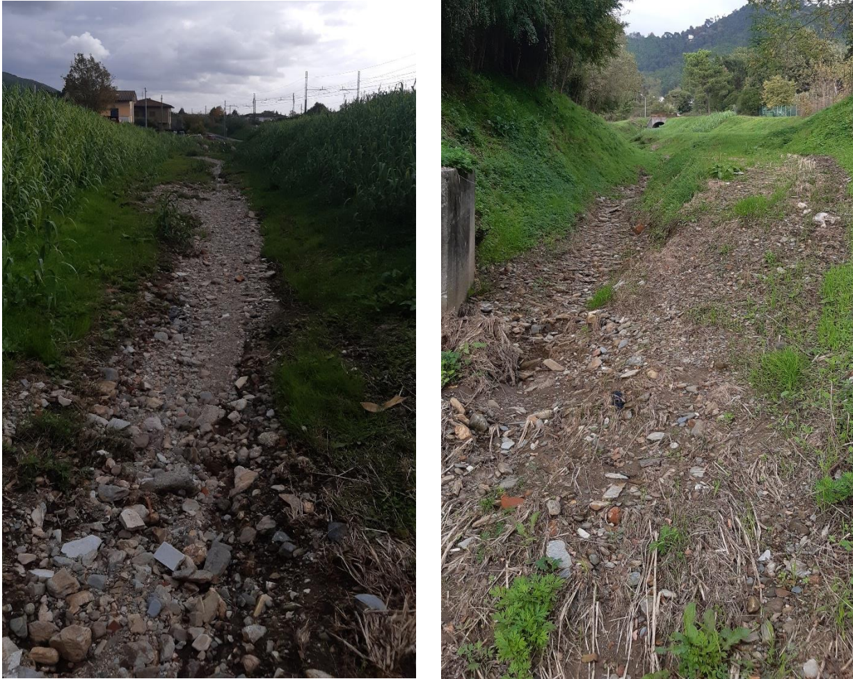
Figura 24 – Torrente Canalmagro – alveo in corrispondenza degli attraversamenti di progetto
