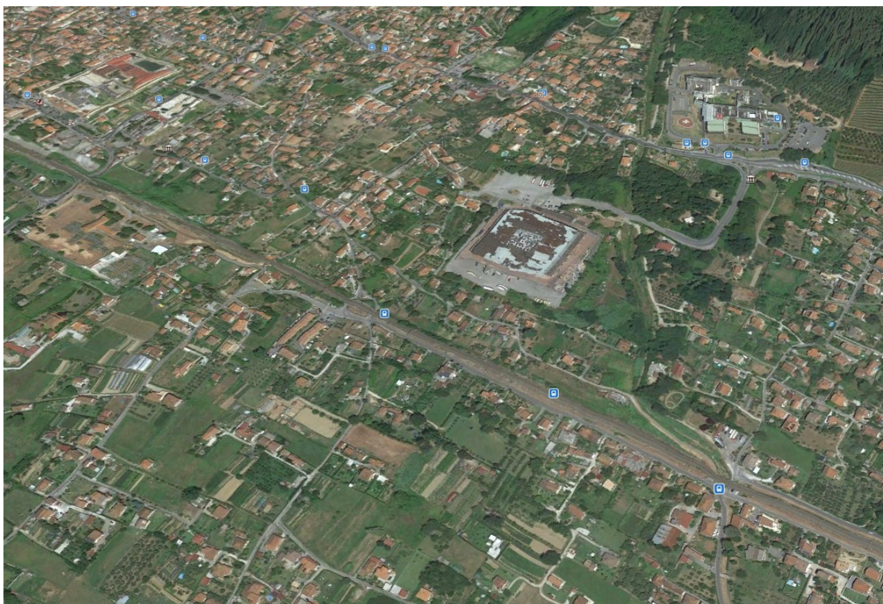
Immagine aerea del tratto di intervento
