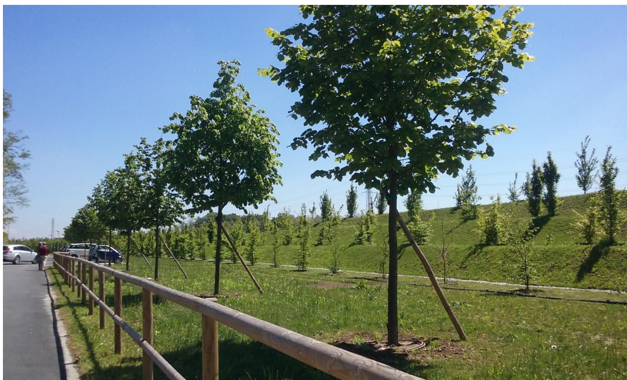
A36 – duna antirumore piantumata a protezione di insediamenti residenziali in comune di Bregnano
