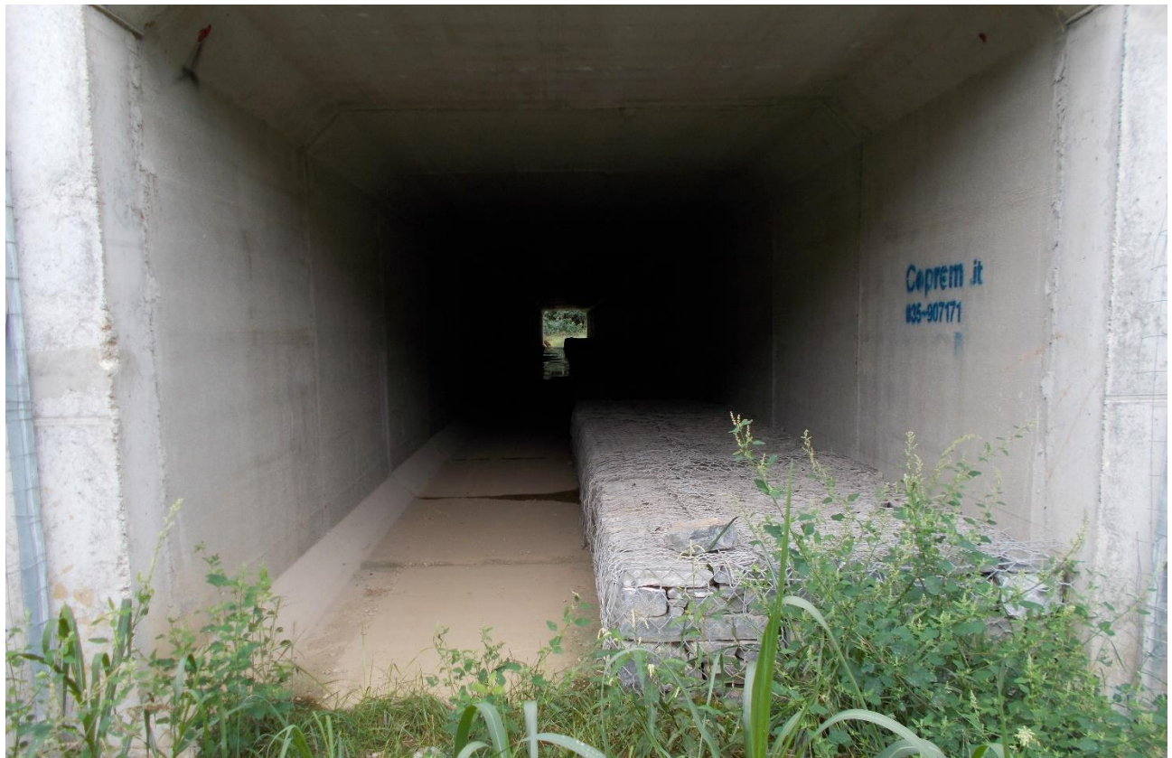
A36 – Passaggio fauna in sottopasso all'autostrada. Le gabbionate permettono di mantenere un passaggio in asciutta per la fauna in caso di allagamento
