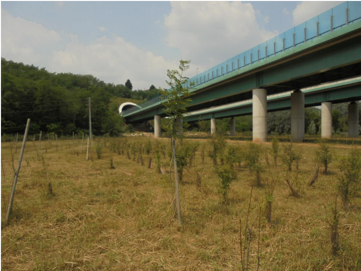
A36 – piantumazione di nuovo bosco al di sotto del viadotto sul fiume Olona
