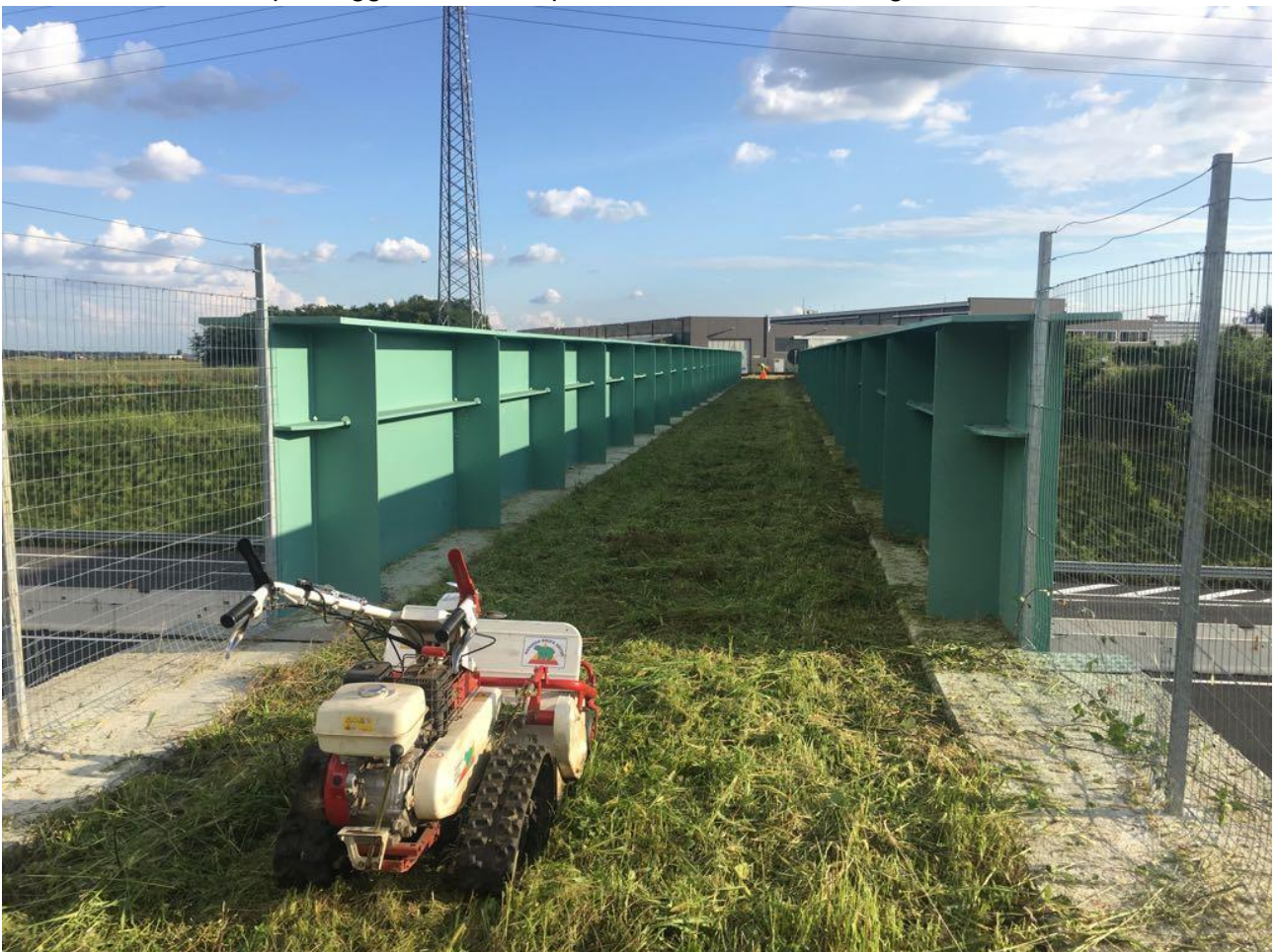
A36 – manutenzione di passaggio fauna su cavalcavia
