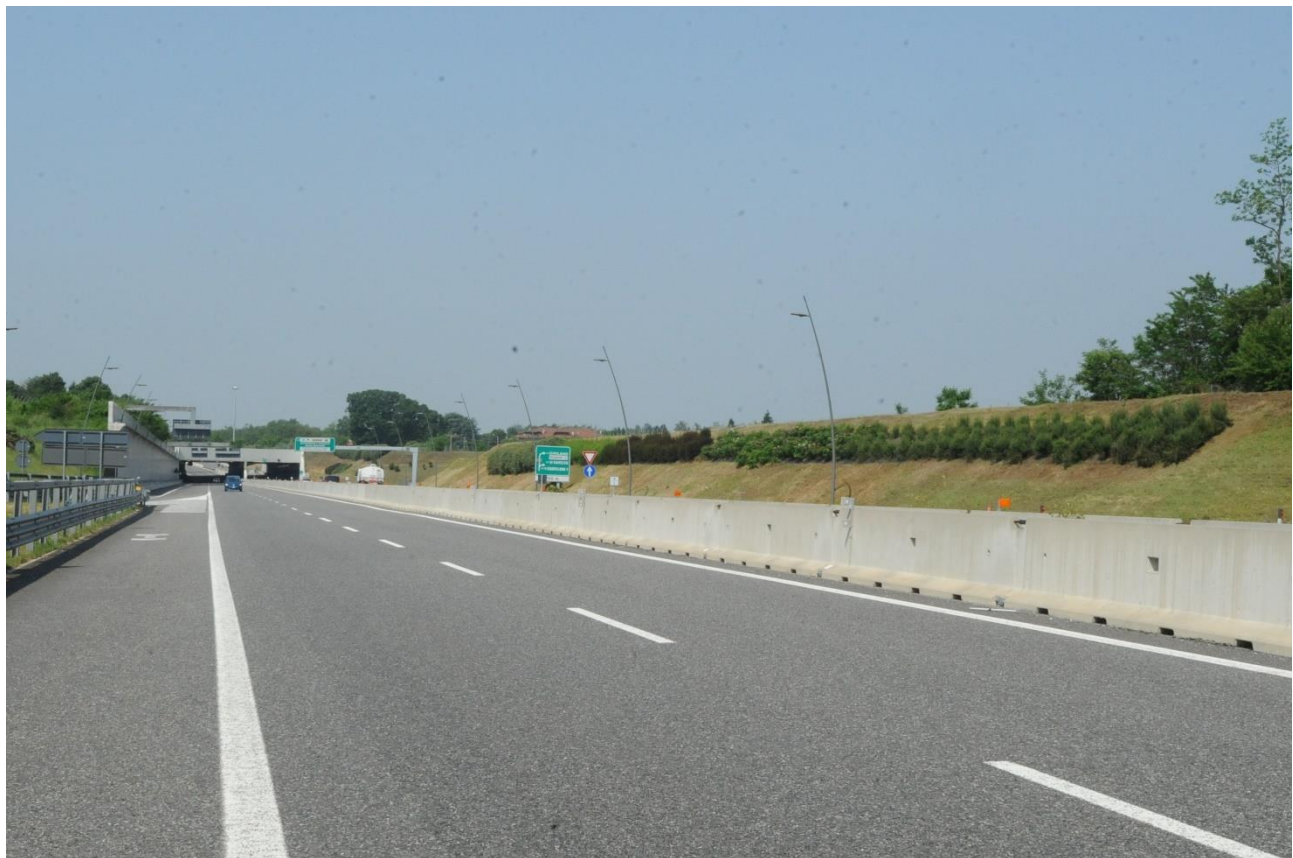
A36 – mitigazioni interne alla recinzione autostradale di un tratto in trincea
