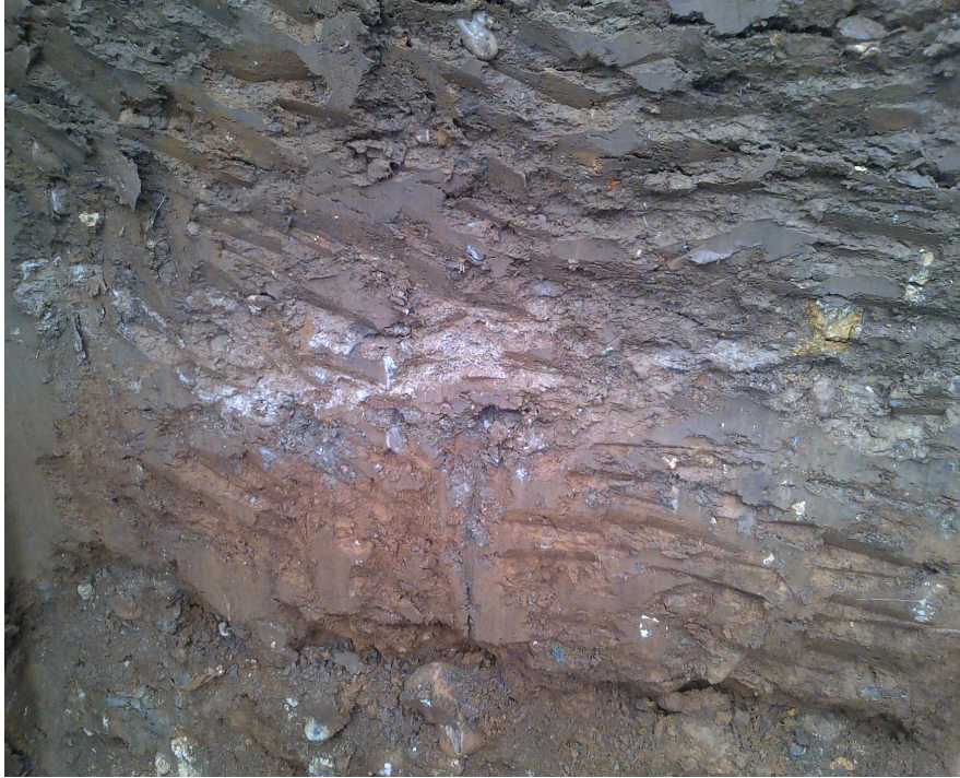
Dettaglio orizzonte C – rilievo SUO-LO-01 del 29/04/2016 – fase PO
