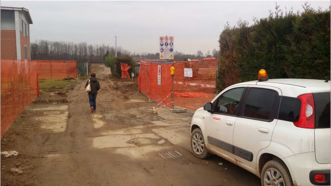
Foto 3 Foto attività di rilievo: cantiere
