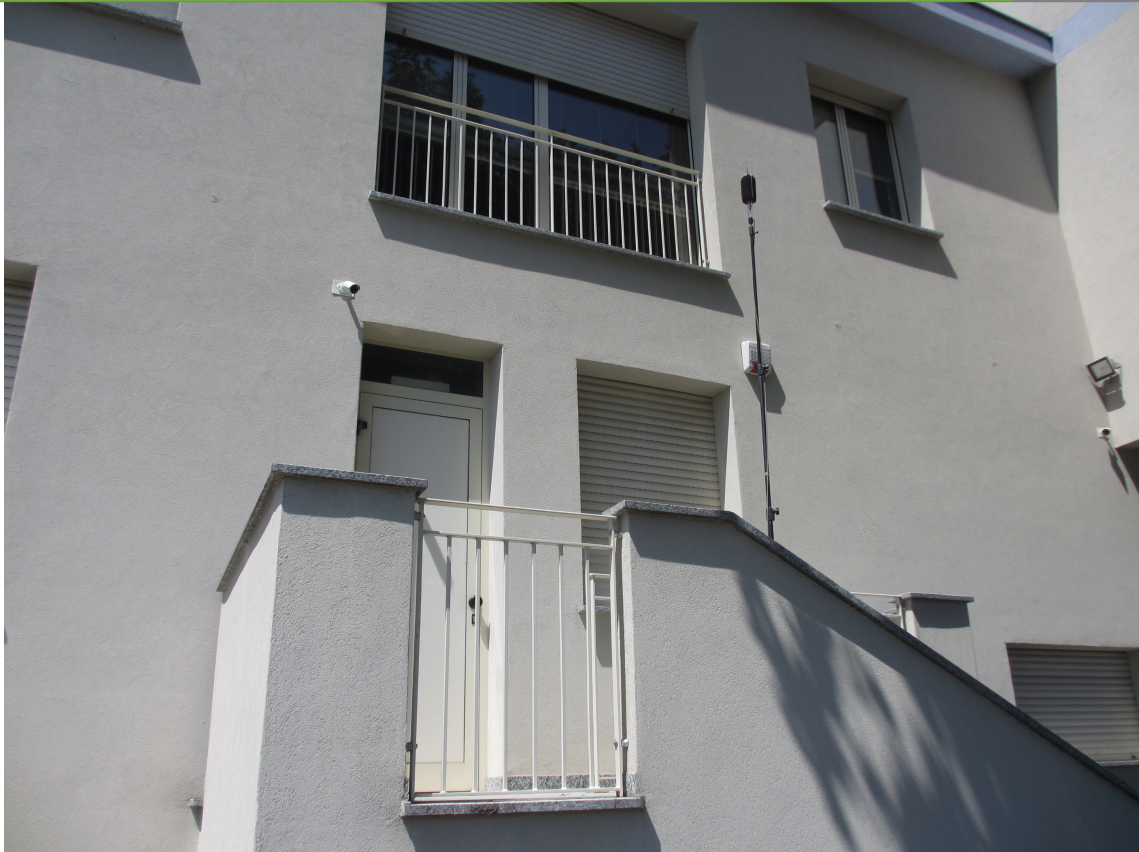
Foto 1 Foto attività di rilievo: fonometro installato
