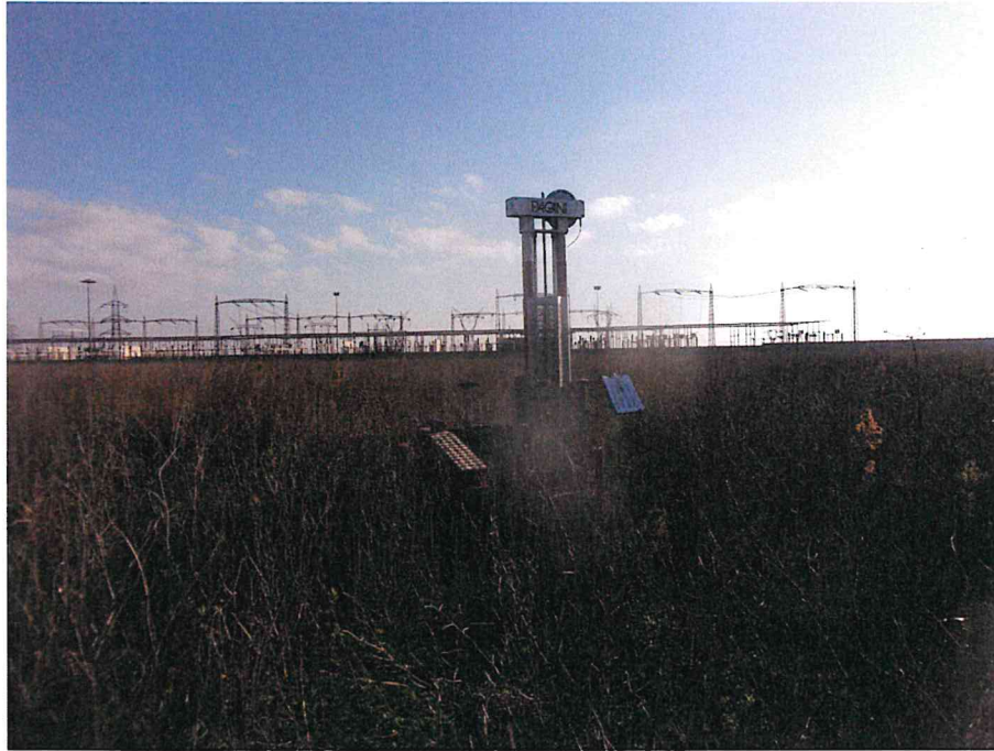
Esecuzione prova penetrometrica
