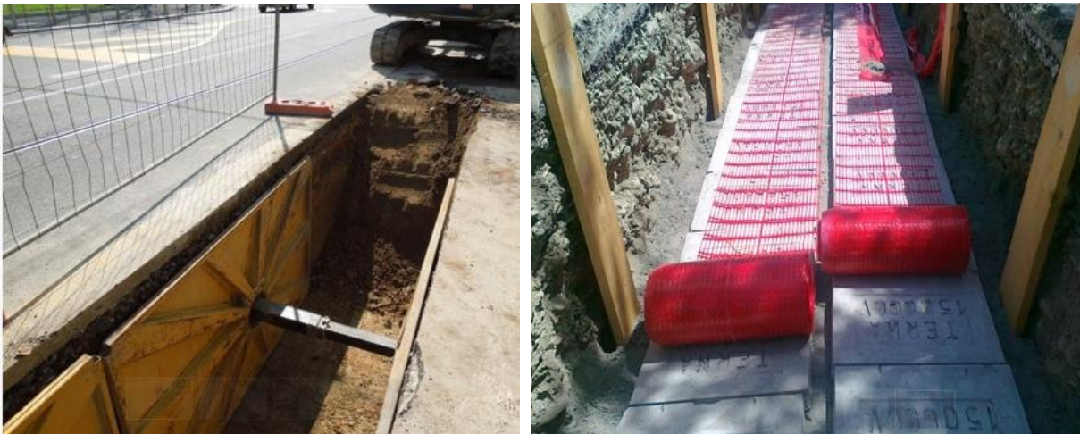
Trincee per posa cavi da interrare
