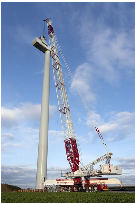
Figura 10 – Una gru tipo Liebherr 1750 durante l’installazione di un generatore eolico
