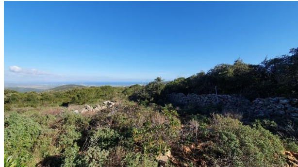
Figura 49. Area della turbina WTG011 da SW.
