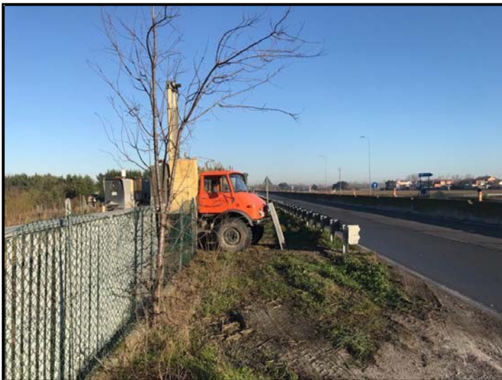
Foto n.36: Esecuzione prova CPTU2
