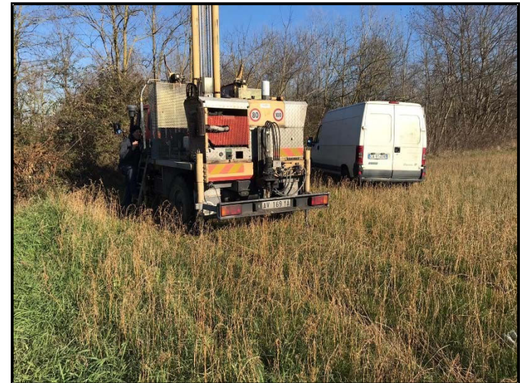
Foto n.38: Esecuzione prova CPTU4
