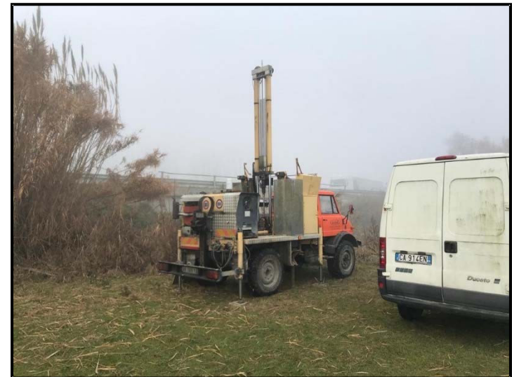
Foto n.42: Esecuzione prova CPTU8
