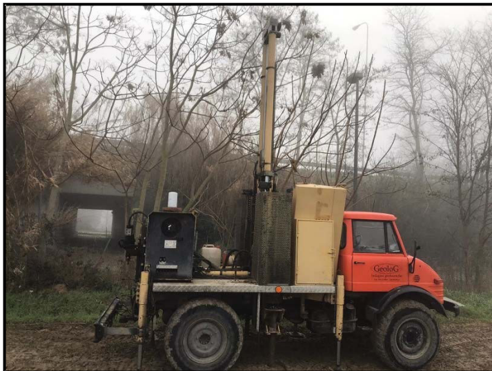
Foto n.40: Esecuzione prova CPTU6
