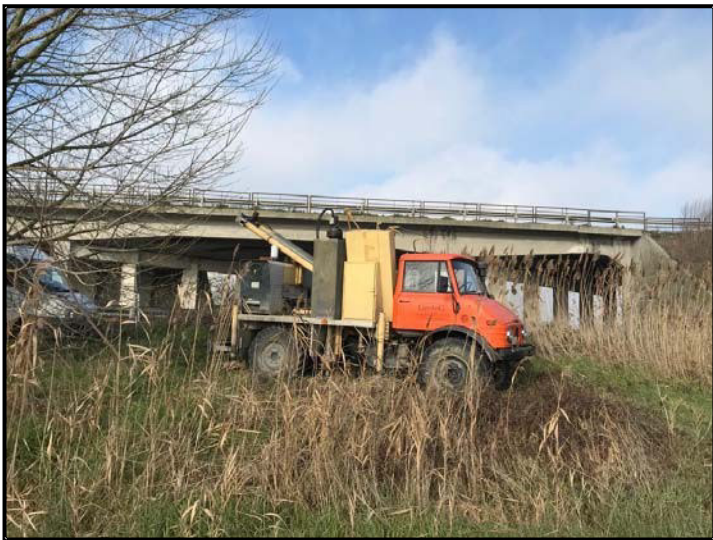
Foto n.44: Esecuzione prova CPTU10
