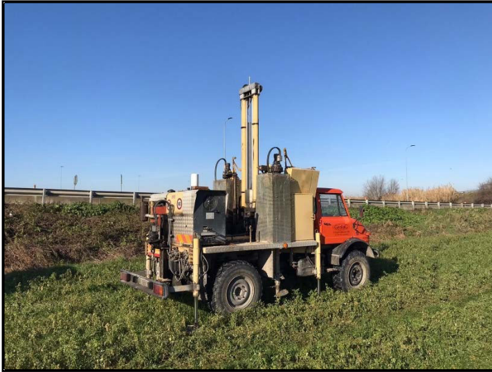
Foto n.35: Esecuzione prova CPTU1
