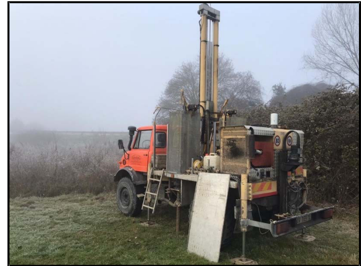
Foto n.41: Esecuzione prova CPTU7
