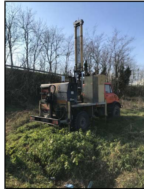
Foto n.45: Esecuzione prova CPTU11
