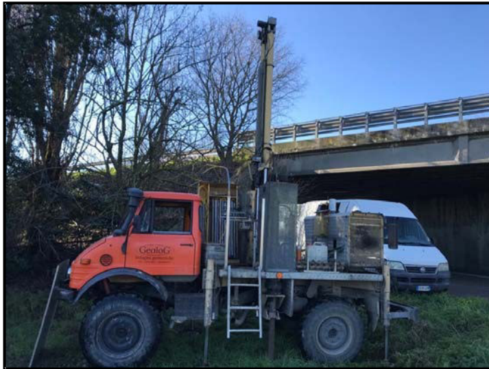
Foto n.39: Esecuzione prova CPTU5
