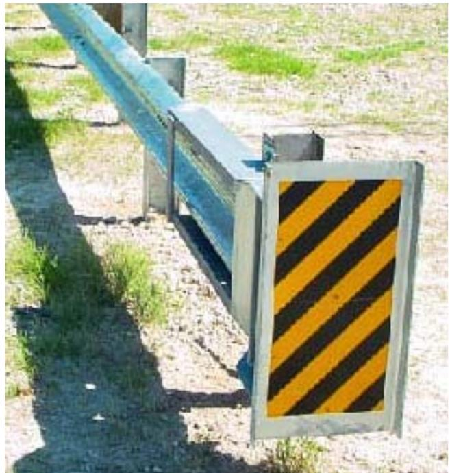
**Figura 5**– Esempio di terminale con attenuatore
