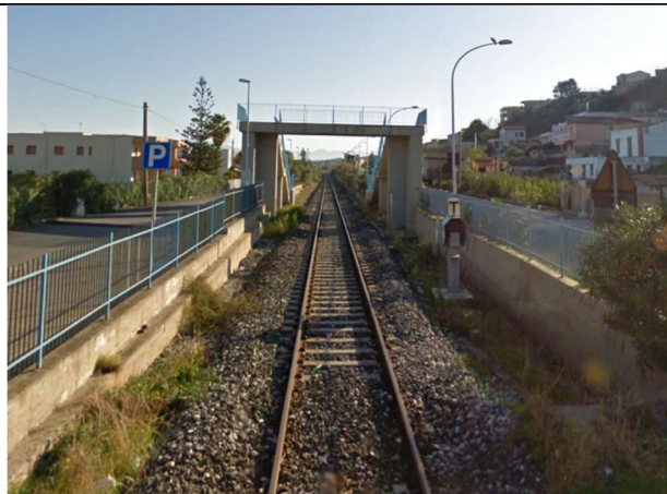
Sede Ferroviaria – Lotto 1
