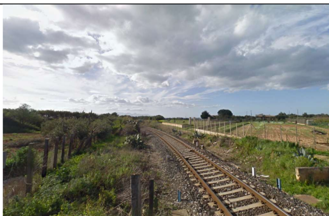
Sede Ferroviaria – Lotto 1
