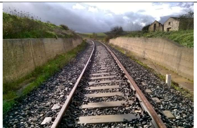
Sede Ferroviaria – Lotto2
