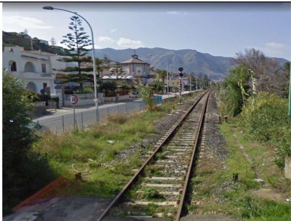
Sede Ferroviaria – Lotto 1
