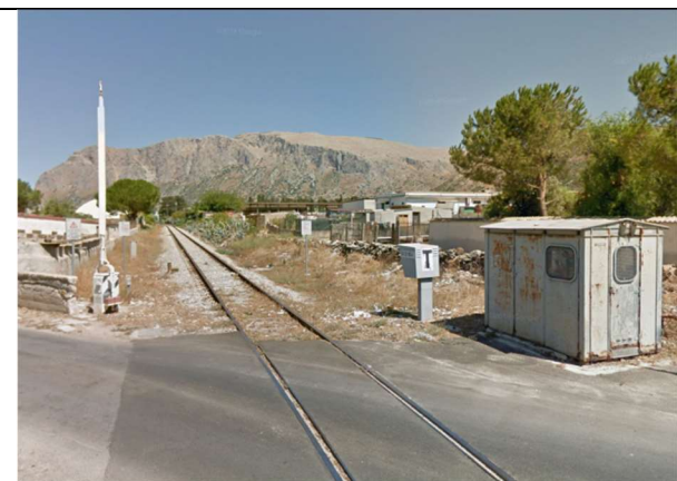
Sede Ferroviaria – Lotto 1
