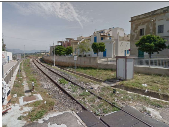
Sede Ferroviaria – Lotto 1
