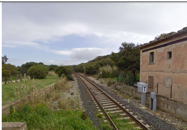
Sede Ferroviaria – Lotto 1
