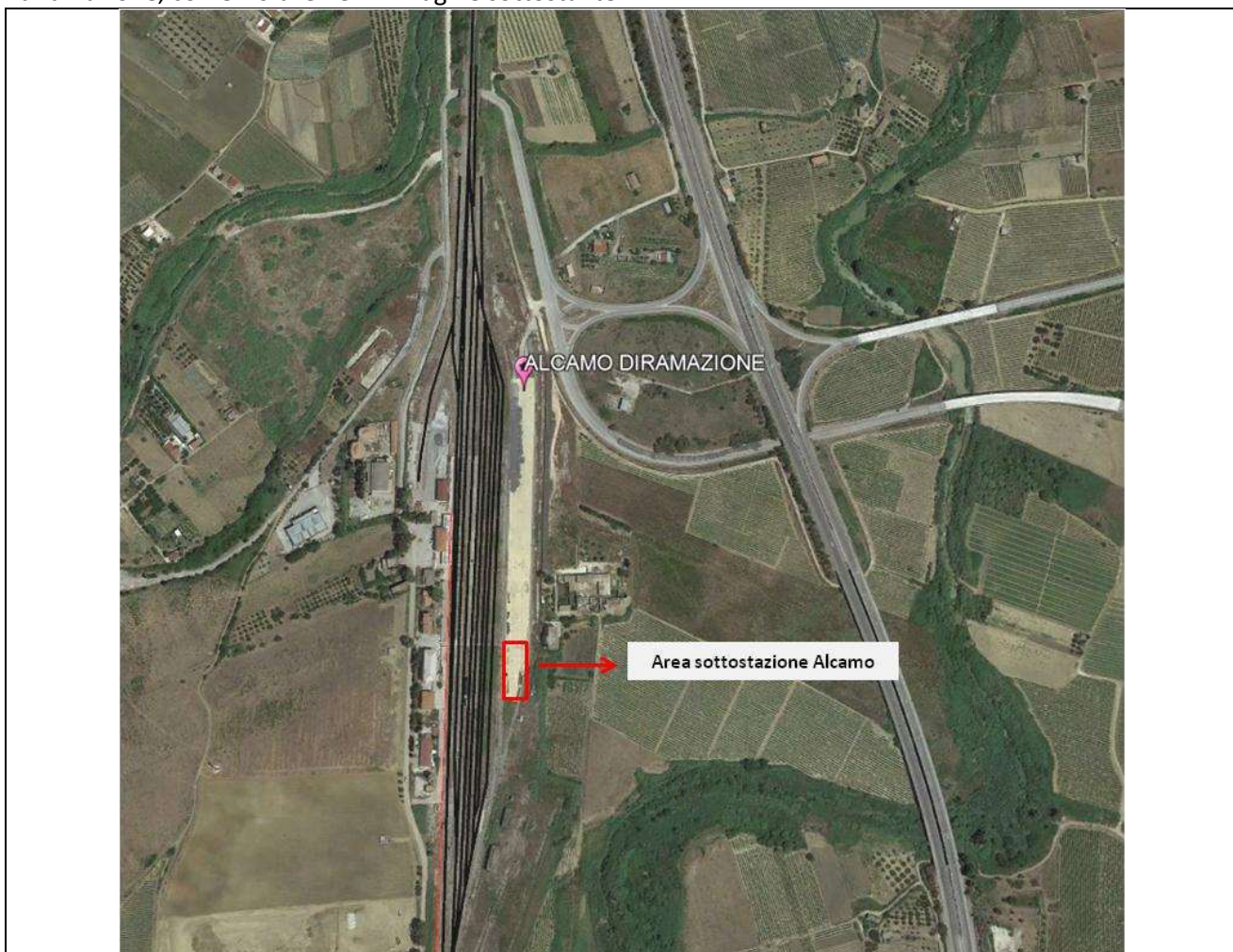
Figura 1 –Localizzazione della sottostazione di Alcamo
