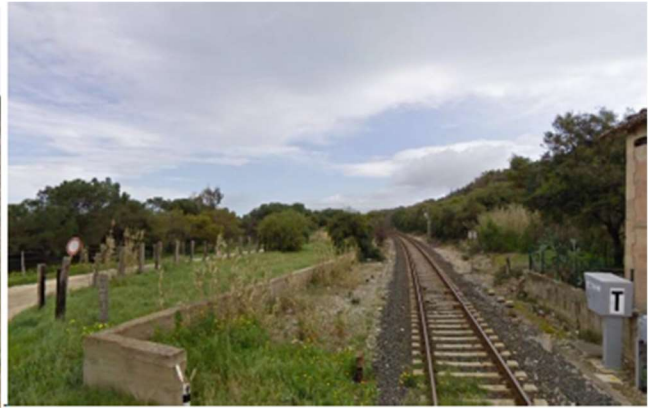
Foto 8 Dall'attraversamento della strada verso est
