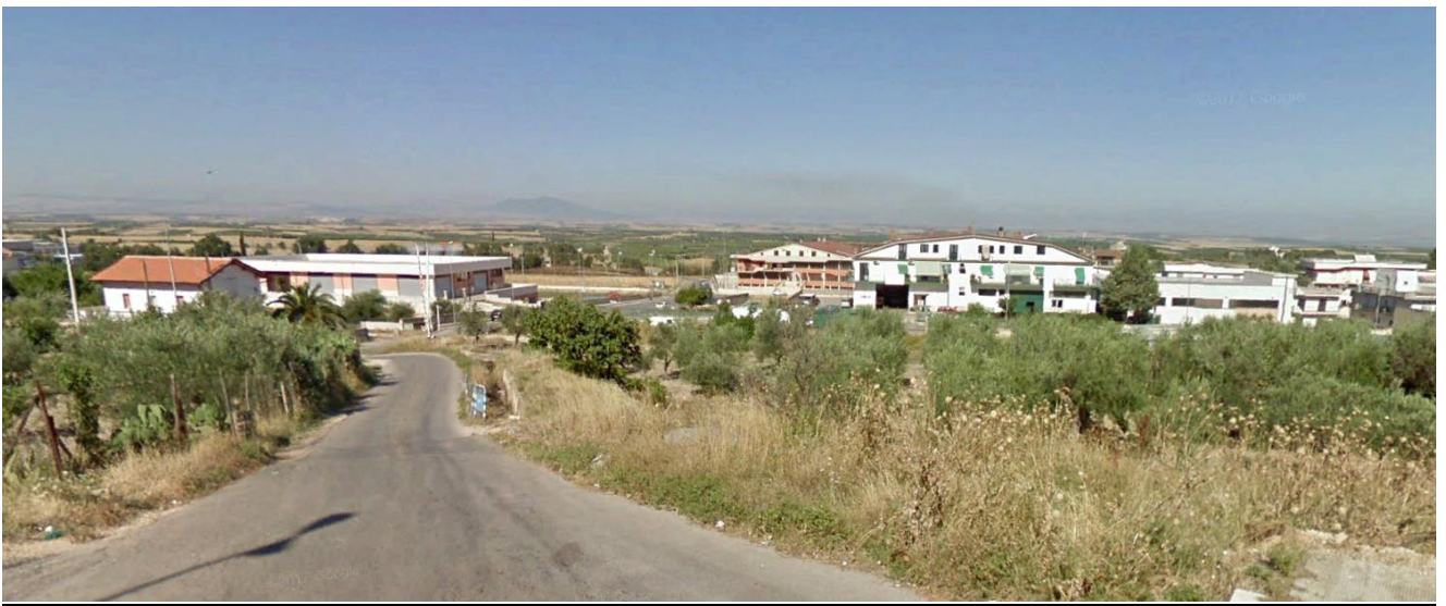
Figura 7-38: Panoramica dal Punto 16 – ante opera
