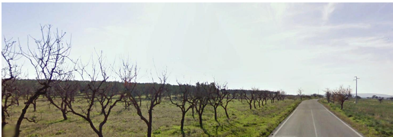
Figura 7-24: Panoramica dal Punto 09 – ante opera
