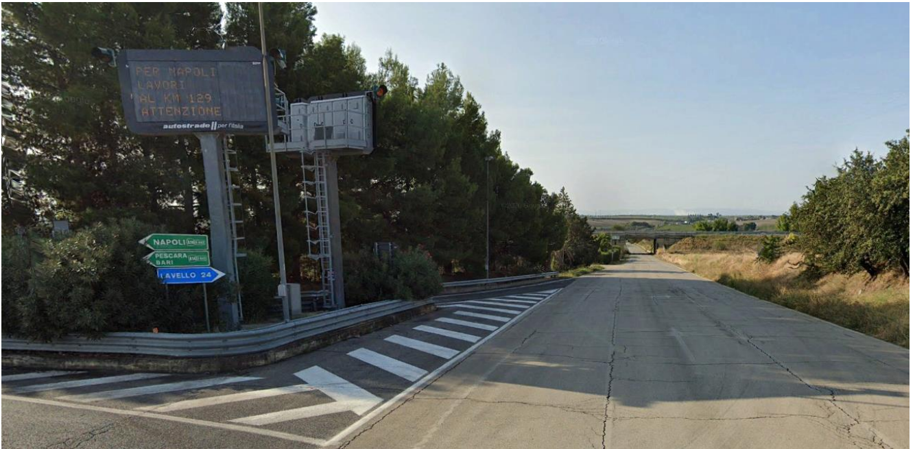
Figura 2-3: SS529 uscita autostrada A16
