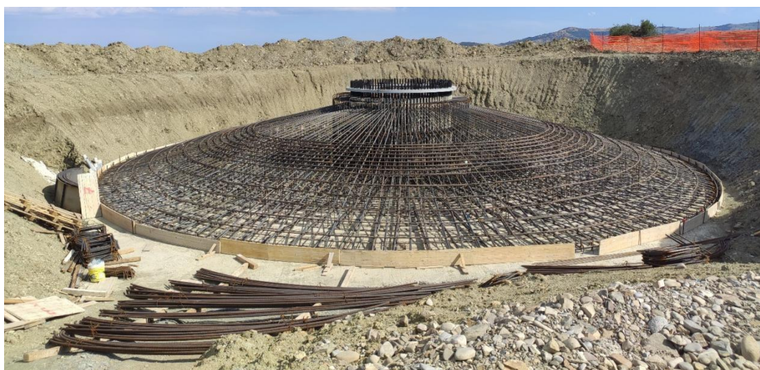
Figura 9: armatura plinto tipo
