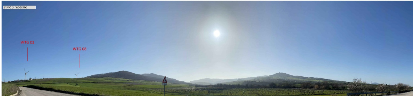
Confronto tra stato di fatto e stato di progetto: punto di presa P2
