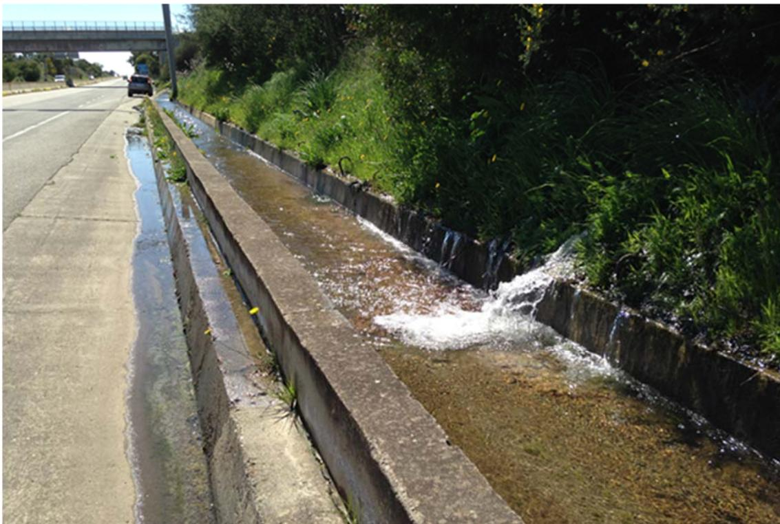
Foto 5 - Venute idriche lungo le scarpate antropiche nel Complesso alluvionale grossolano, all'altezza del km 22+500.
