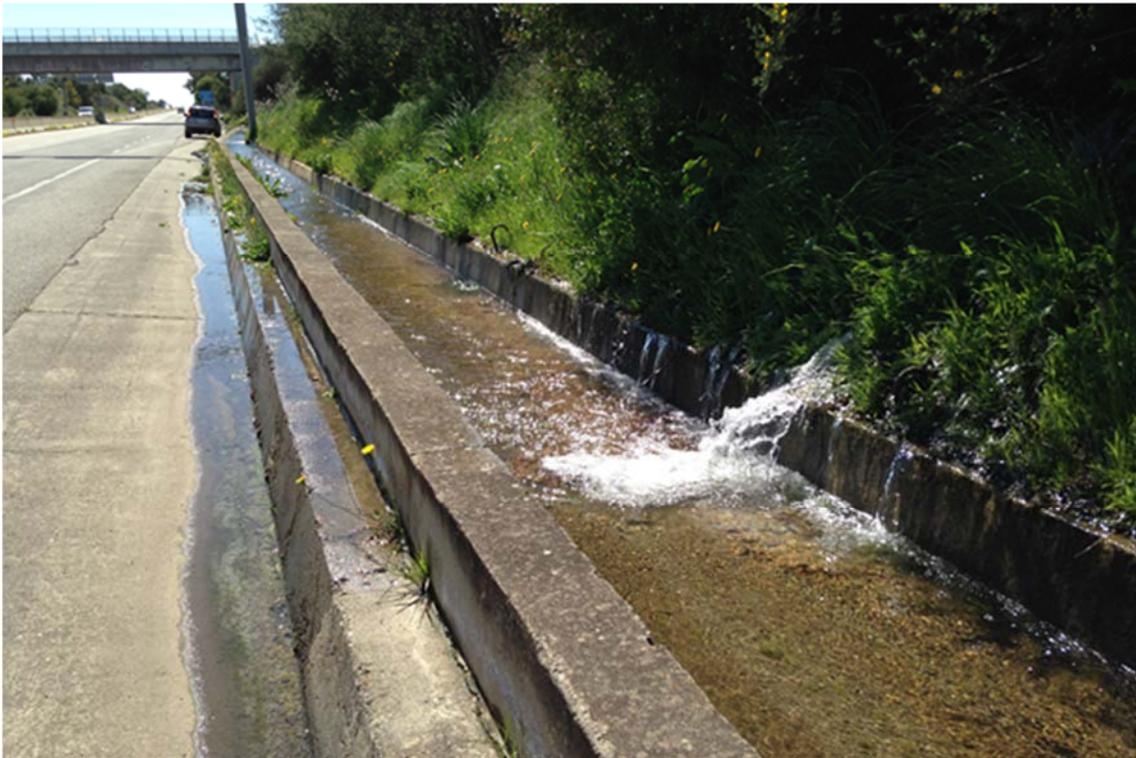
*Foto 4 - Venute idriche lungo le scarpate antropiche nel Complesso alluvionale grossolano, all'altezza del km 22+500.*
